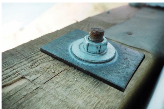
Rys. 11. Dodatkowa płytka dociskowa ograniczająca obrót murlaty.
