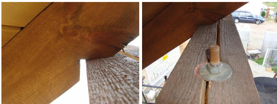
Rys. 7. Przykład awarii połączenia krokiew-murłata z dodatkowym rozwarstwieniem murłaty. Połączenie z użyciem wkrętu ciesielskiego.
