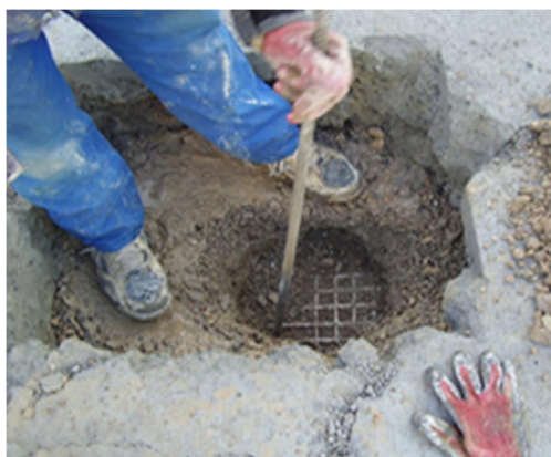
Rys. 7. Wycinanie pierwszej siatki georusztu.
