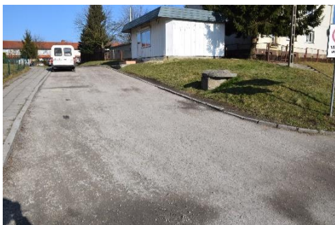
Rys. 1. Widok ogólny odcinka 1.
