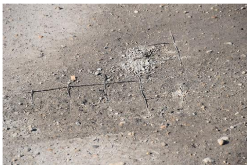
Rys. 5. Widok odsłoniętej siatki stalowej.
