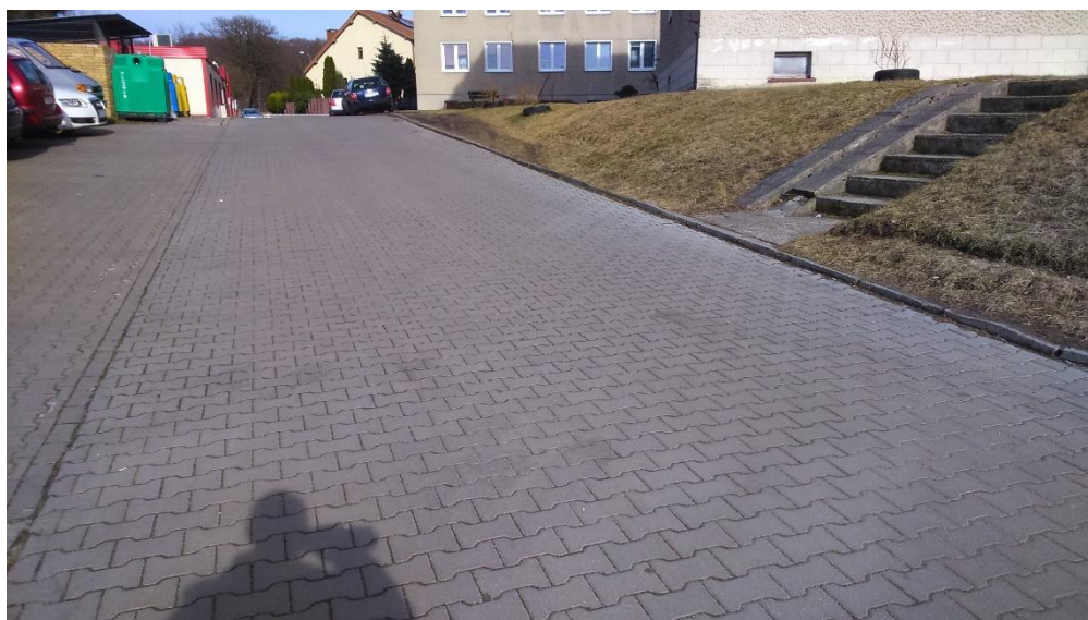
Rys. 10. Widok nawierzchni po wykonaniu działań naprawczych.
