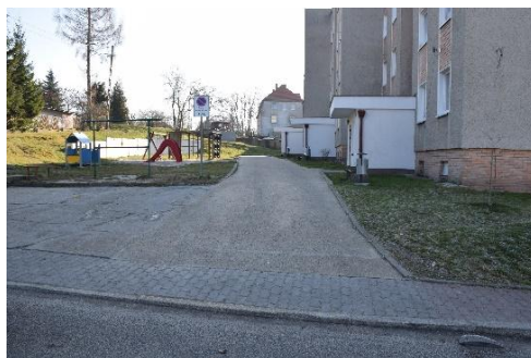
Rys. 2. Widok ogólny odcinka 2.
