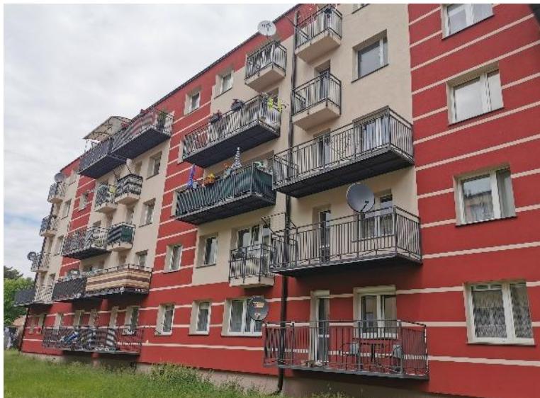
Rys. 11. Polska, Koziennice 2020, fragment elewacji budynku prefabrykowanego. Podczas ocieplania ścian wykonano remont kapitalny części małych balkonów a pozostałe wymieniono na balkony dostawne o konstrukcji stalowej z panelami PCV. Dodano też balkony w parterze.
