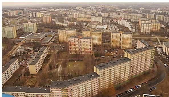
Rys. 1. Widok fragmentu typowych lubelskich osiedli z budynkami wykonanymi w systemach prefabrykowanych.
