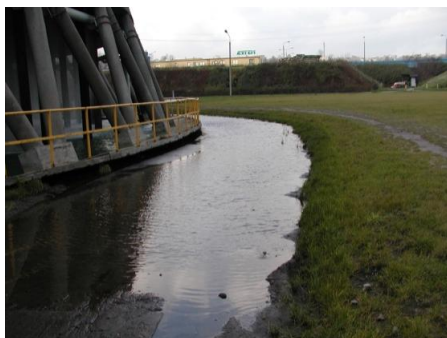
Rys. 4. Przykład przelania chłodni oraz nieszczelności zewnętrznej części rurociągu wody technologicznej.
