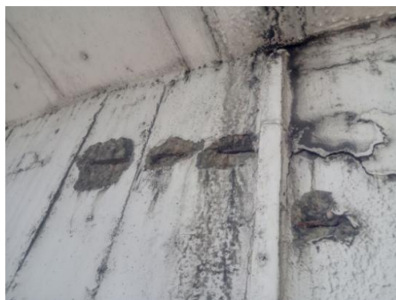
Rys. 9. Przykłady powierzchniowych i wgłębnych uszkodzeń korozyjnych na zewnętrznej powierzchni płaszcza chłodni.
