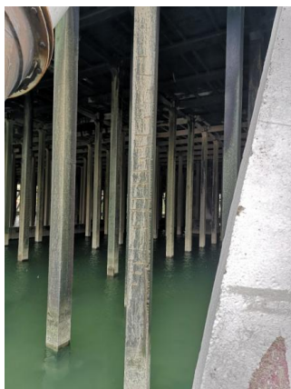
Rys. 14. Przykłady efektów korozji zbrojenia w wewnętrznych słupach pod zraszalnikiem.
