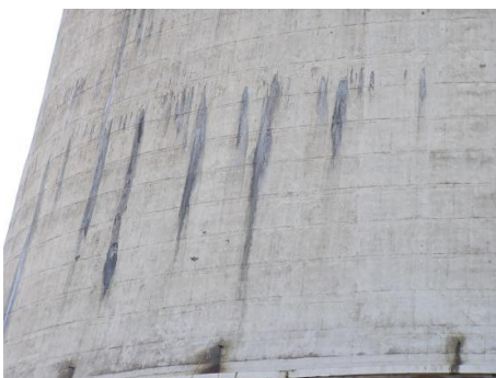
Rys. 10. Przykłady wycieków wody na zewnętrznej powierzchni płaszcza chłodni.
