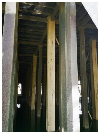
Rys. 14. Przykłady efektów korozji zbrojenia w wewnętrznych słupach pod zraszalnikiem.
