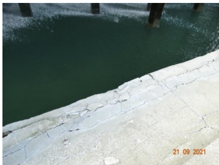
Rys. 3. Przykłady uszkodzeń tacy ociekowej.
