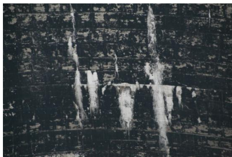
Rys. 11. Przykłady odspojień powłoki ochronnej oraz wycieków węglanu wapnia na wewnętrznej powierzchni płaszcza chłodni.
