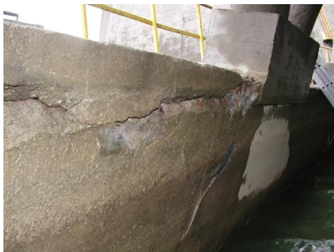
Rys. 2. Przykładowe wady i uszkodzenia przy górnej krawędzi misy chłodni.
