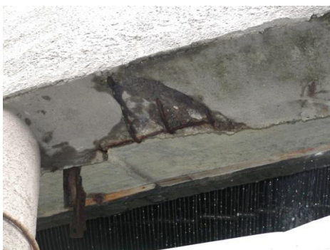
Rys. 12. Przykłady uszkodzeń korozyjnych w obrębie dolnej krawędzi płaszcza chłodni (z prawej – po odkuciu otuliny).
