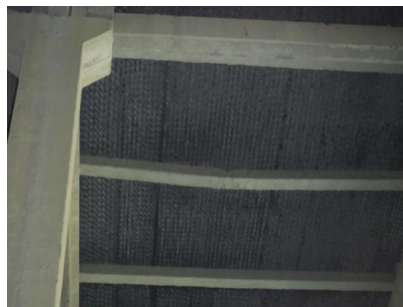
Rys. 15. Przykłady typowych uszkodzeń w belkach pod zraszalnikiem.
