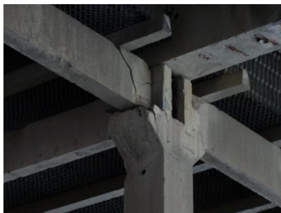
Rys. 15. Przykłady typowych uszkodzeń w belkach pod zraszalnikiem.
