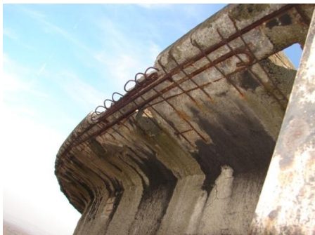
Rys. 13. Przykłady uszkodzeń korozyjnych w obrębie górnej galerii.
