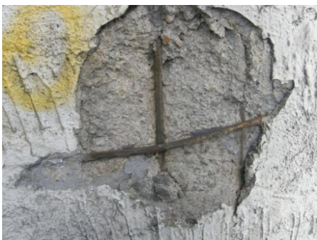
Rys. 9. Przykłady powierzchniowych i wgłębnych uszkodzeń korozyjnych na zewnętrznej powierzchni płaszcza chłodni.
