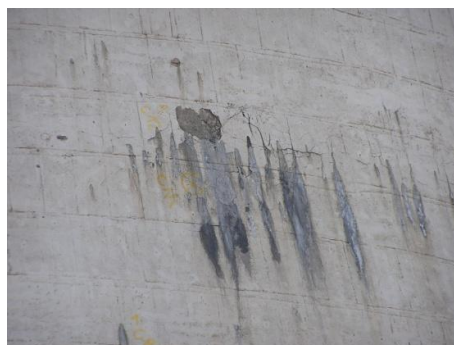
Rys. 10. Przykłady wycieków wody na zewnętrznej powierzchni płaszcza chłodni.
