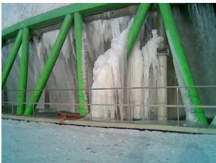
Rys. 8. Przykłady oblodzenia słupów chłodni.
