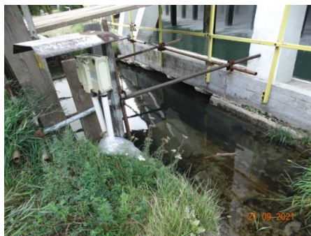
Rys. 4. Przykład przelania chłodni oraz nieszczelności zewnętrznej części rurociągu wody technologicznej.
