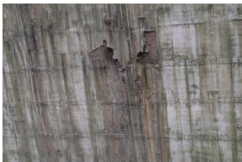
Rys. 11. Przykłady odspojień powłoki ochronnej oraz wycieków węglanu wapnia na wewnętrznej powierzchni płaszcza chłodni.
