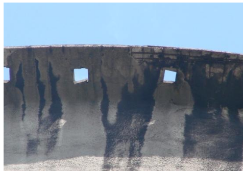
Rys. 13. Przykłady uszkodzeń korozyjnych w obrębie górnej galerii.
