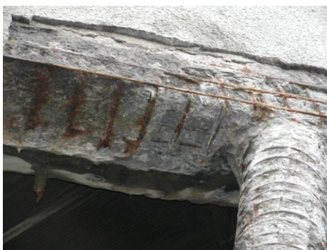
Rys. 12. Przykłady uszkodzeń korozyjnych w obrębie dolnej krawędzi płaszcza chłodni (z prawej – po odkuciu otuliny).
