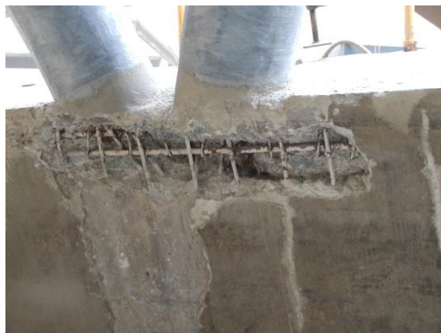
Rys. 2. Przykładowe wady i uszkodzenia przy górnej krawędzi misy chłodni.
