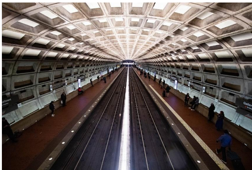
Rys. 4. Podziemna stacja metra WMATA z betonowych łuków przypominających katedrę.
