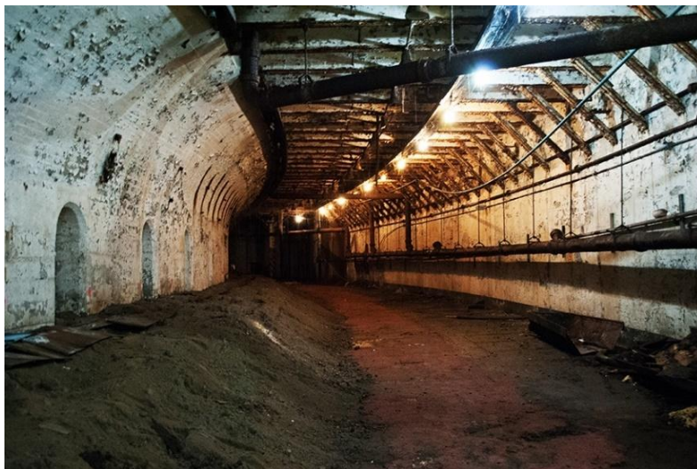
Rys. 2. Opuszczony MBTA Tunnel.
