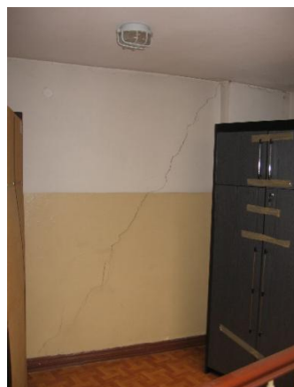
Fot. 5, 6. Spękania ściany północno-zachodniej (fot. B. Nowogońska).
