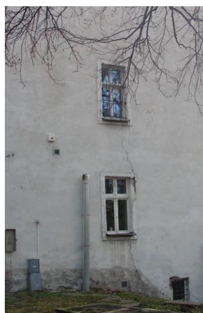
Fot. 3, 4. Fragment pionowej rysy przebiegającej od fundamentów do okapu na elewacji północno-zachodniej (fot. B. Nowogońska).
