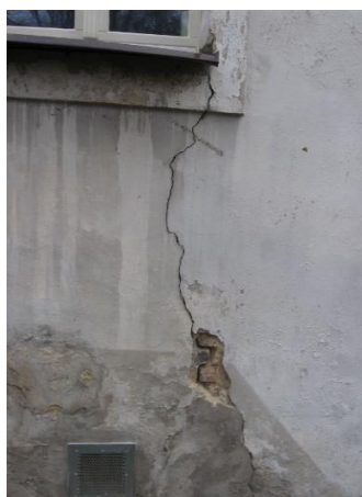
Fot. 3, 4. Fragment pionowej rysy przebiegającej od fundamentów do okapu na elewacji północno-zachodniej (fot. B. Nowogońska).
