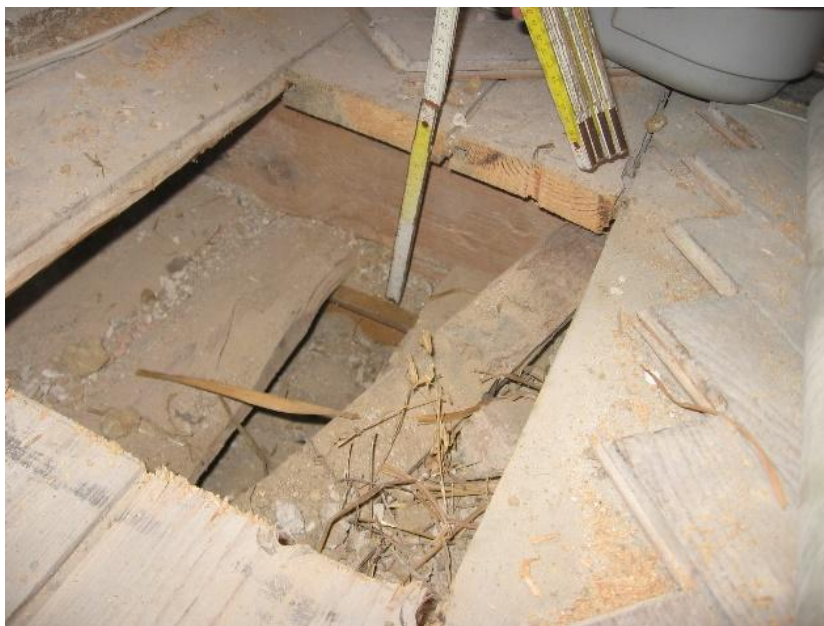
Fot. 12. Odkrywka stropu nad parterem.
