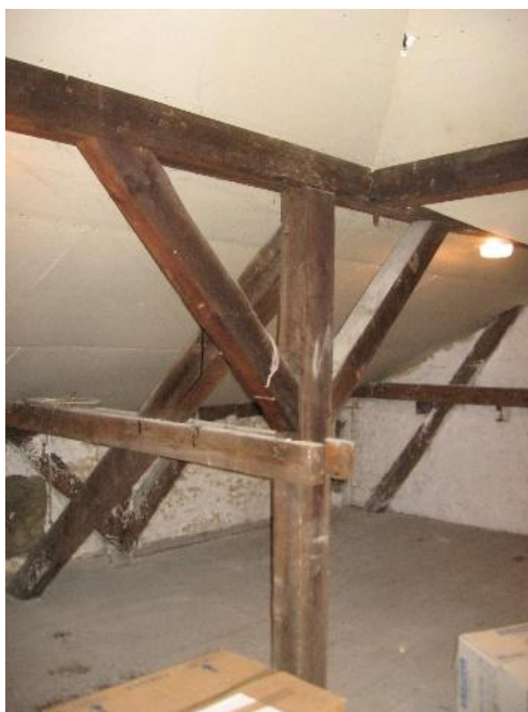
Fot. 13. Fragment więźby dachowej (fot. B. Nowogońska).
