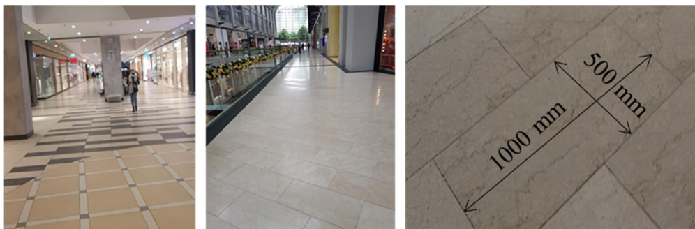
Rys. 1. Przykładowe podłogi wielkopowierzchniowe w dużych reprezentacyjnych obiektach handlowych z wierzchnią warstwą kamienną.
