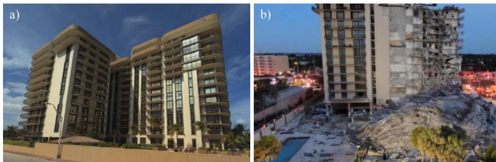
Rys. 1. Widok ogólny budynku a) w 2015 r. Źródło:[2] b) dzień po katastrofie. Źródło: [3].
