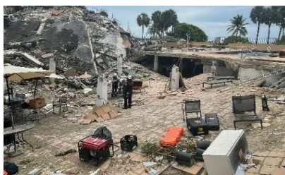
Rys. 12. Zapadnięty strop nad garażem – widoczne skutki przebicia. Źródło:[12].
