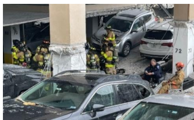
Rys. 12. Zapadnięty strop nad garażem – widoczne skutki przebicia. Źródło:[12].
