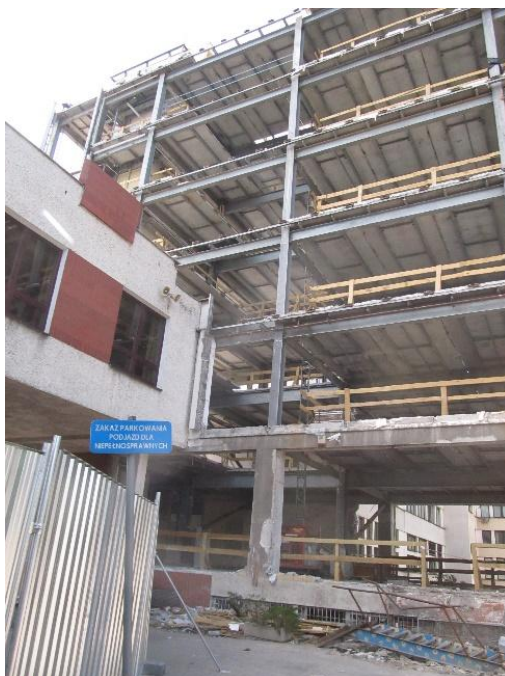
Rys. 7. Widok robót rozbiórkowych (osie 2 i 3 oraz frontowa oś A) (fot. własna).
