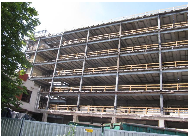
Rys. 6. Widok budynku w trakcie robót rozbiórkowych (fot. własna).
