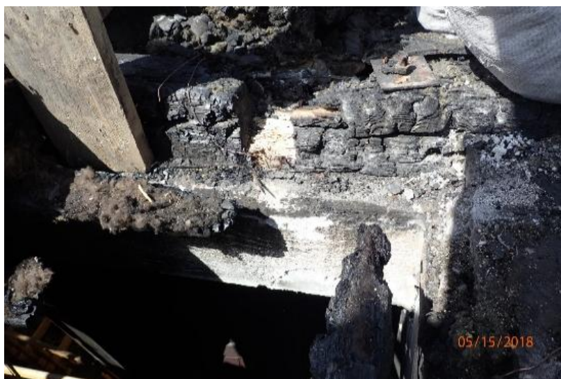
Rys. 4. Widok jednej z odkrywek elementów żelbetowych konstrukcji budynku (fot. własna).
