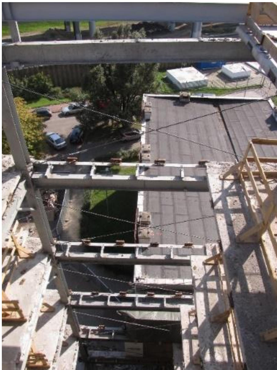
Rys. 11. Widok ściągów stalowych w osi A (fot. własna).
