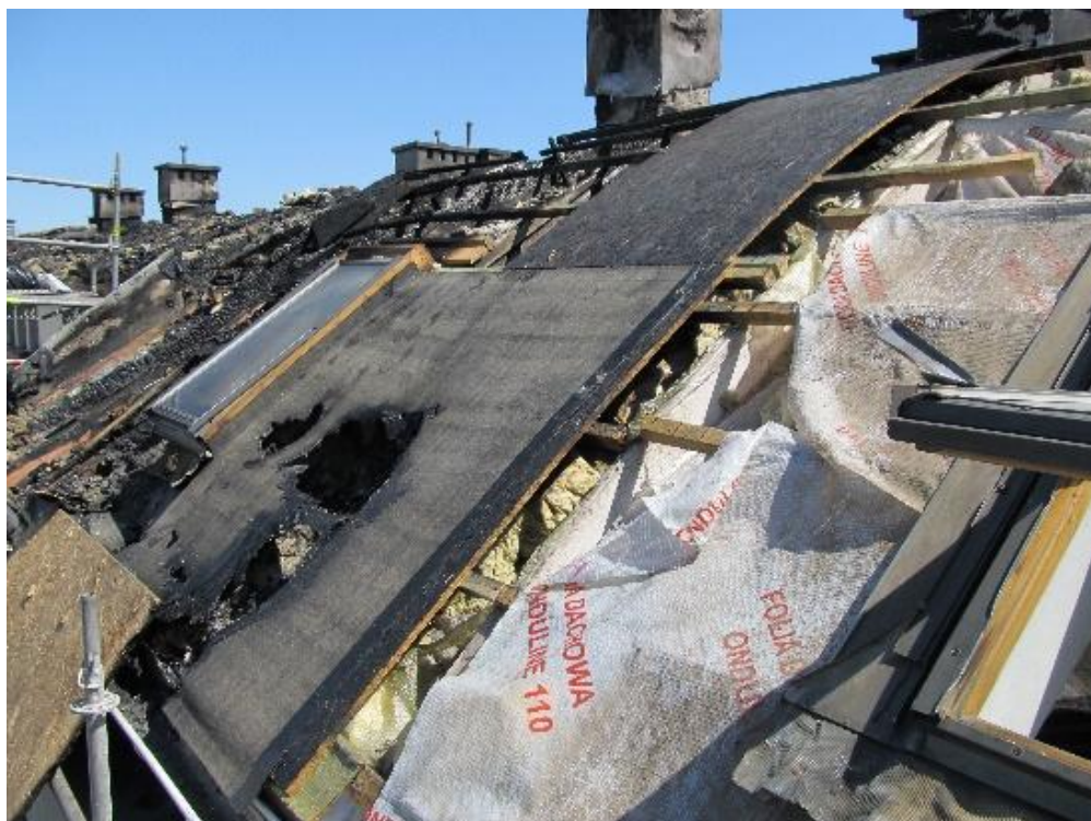
Rys. 5. Widok papy zgrzewalnej na zagruntowanej płycie OSB (fot. własna).
