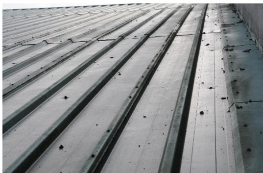
Rys. 5. Widok pokrycia dachowego.
