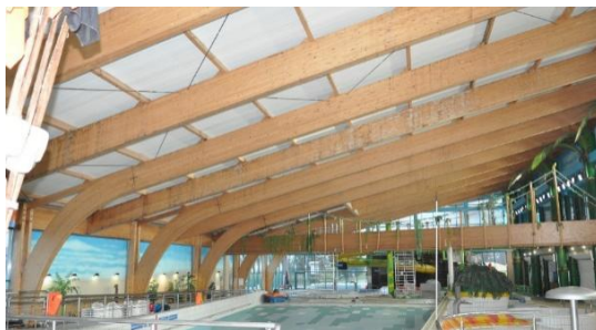
Rys. 4. Widok konstrukcji drewnianej zadaszenia hali basenów rekreacyjnych.
