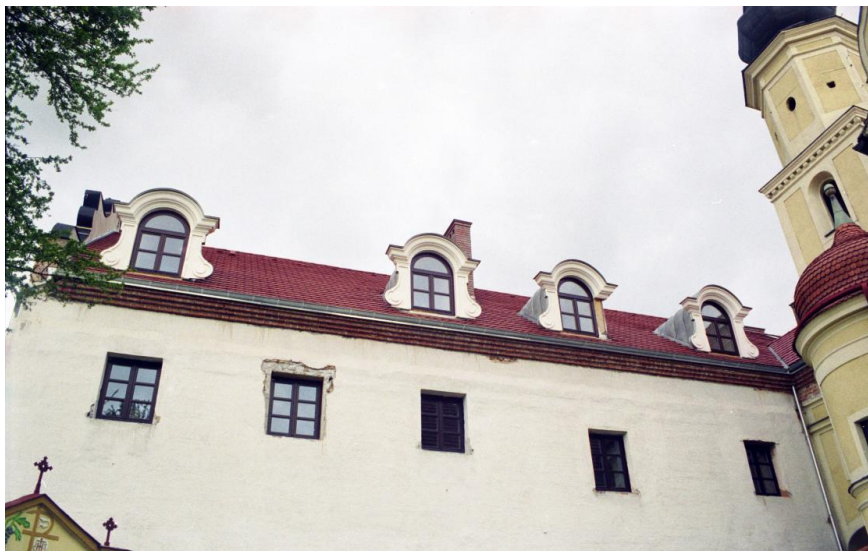
Rys. 9. Klasztor zakonu paulinów, Mochów. W trakcie remontu. Fot. autor.
