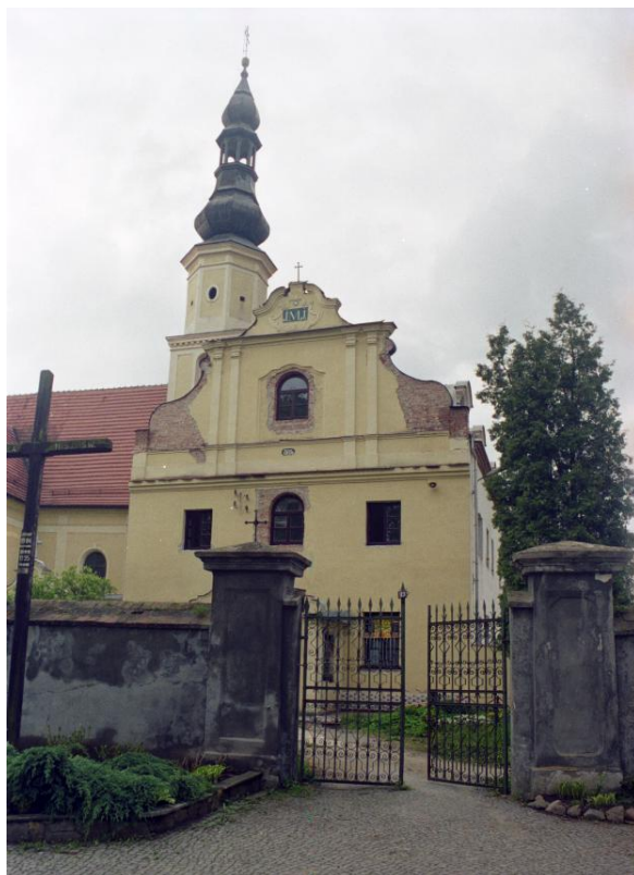
Rys. 8. Klasztor zakonu paulinów, Mochów. W trakcie remontu. Fot. autor.
