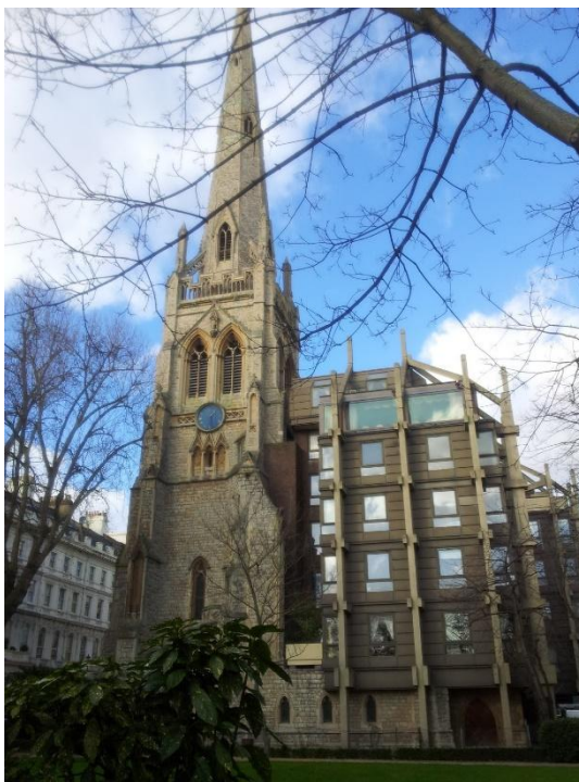
Rys. 7. Spire House, Londyn. Fot. autor.
