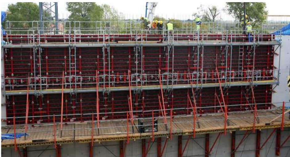
Rys. 2. Deskowania ścienne MAXIMO wyposażone w pomosty roboczo-betoniarskie MXP
