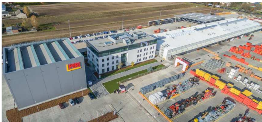
Rys. 4. Centrum logistyczne PERI w Płochocinie po modernizacji
