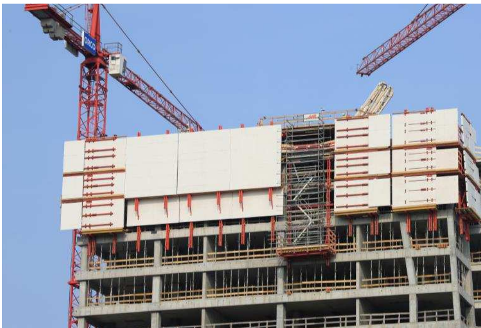
Rys. 3. Osłony zabezpieczające RCS-P z widoczną schodnią rusztowaniową. Budynek Żłota 44 w Warszawie
