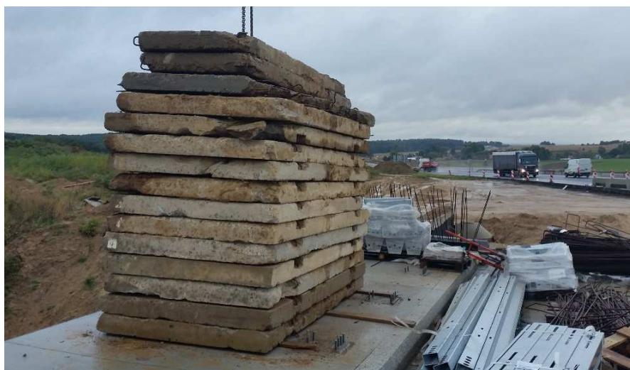
Rys. 10. Balast z płyt betonowych
