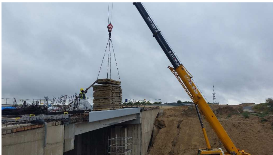
Rys. 14. Układanie płyt nad skrajną belką
