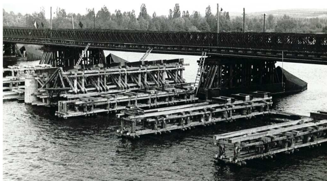
Rys. 2 Most z przęslami systemu Bailey’a. Obok początek budowy nowego mostu
