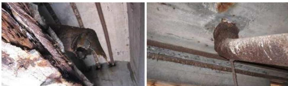
Rys. 13. Rura spustowa odwodnienia nawierzchni w przęśle zachodnim
