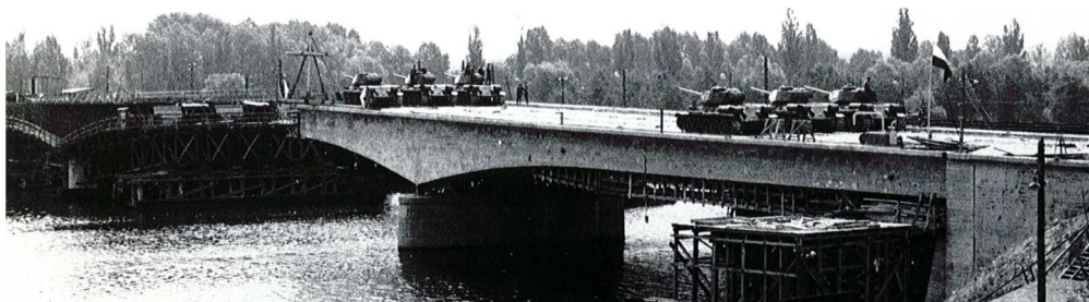
Rys. 9. Badanie naprawionego przęsła zachodniego. Widoczne deskowanie służące do obetonowania sprężenia zewnętrznego
