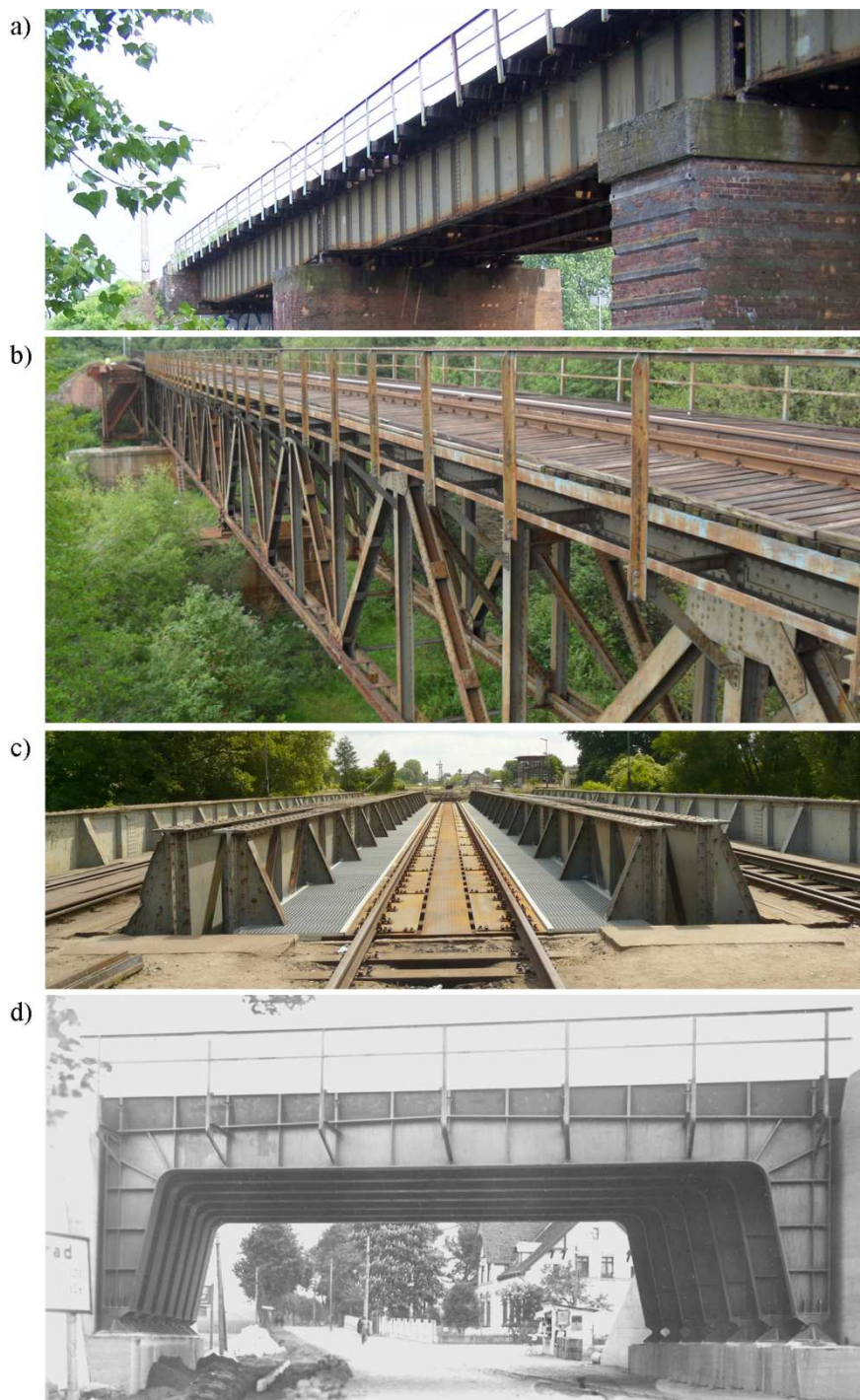
Rys. 1. Cztery badane mosty: a) most nr 1 z 1873 r. na linii nr 353 Poznań-Skandawa, b) most nr 5 z 1875 na linii nr 275 Wrocław-Gubinek, c) most nr 10 z 1887 r. na linii nr 367 Zbąszynek-Gorzów Wlkp., d) wiadukt nr 15 z 1935 r. na linii nr 351 Poznań-Szczecin
