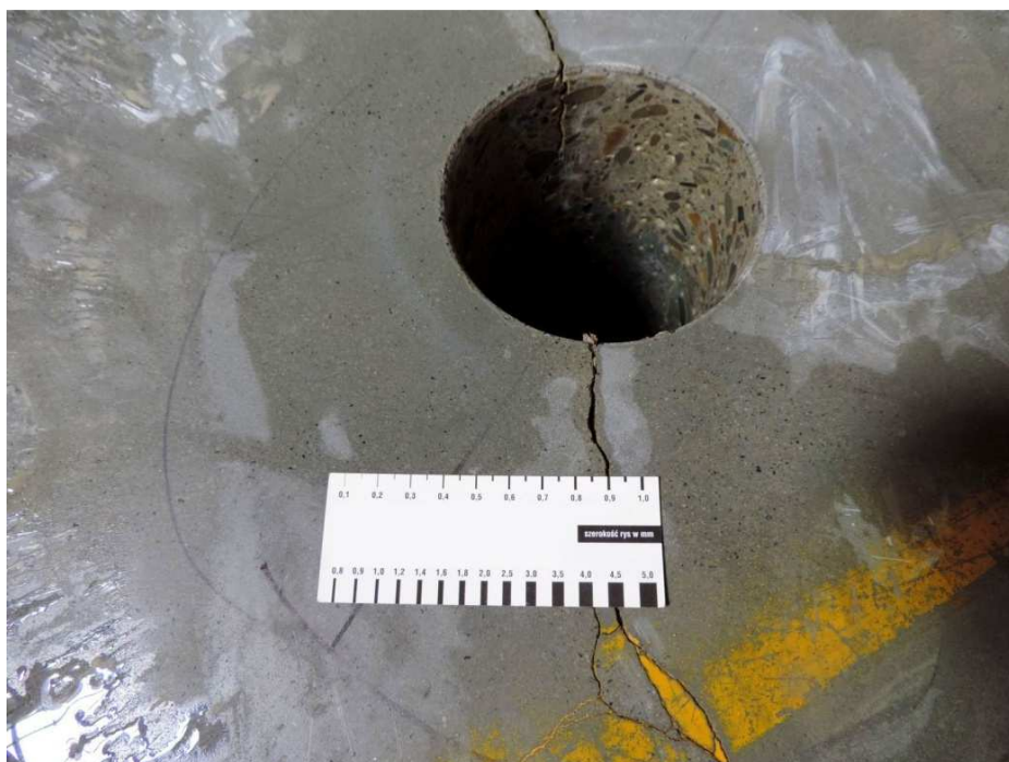
Rys. 2. Rozwarcie rysy na drodze transportowej
