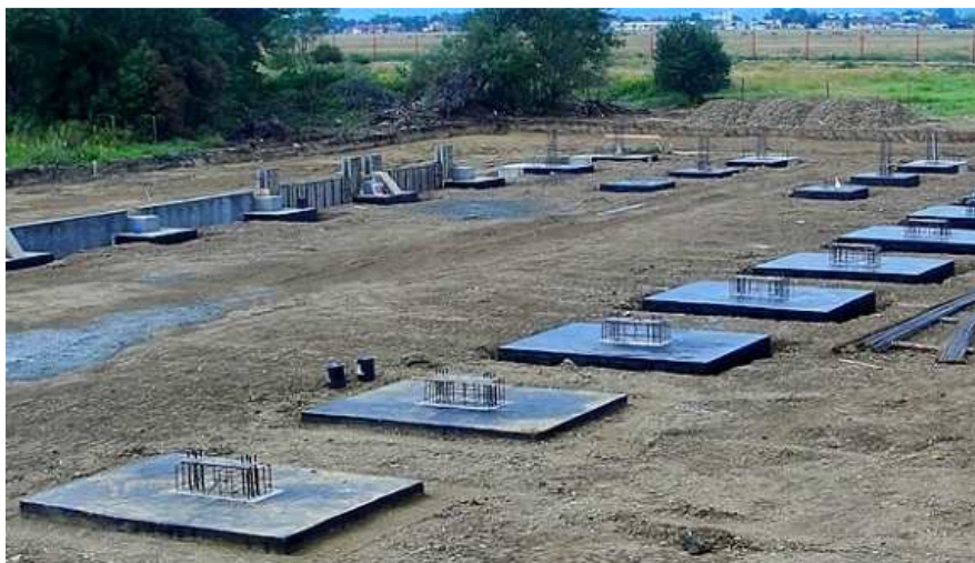
Rys. 9. Stopy fundamentowe w czasie wykonywania podłoża pod posadzkę
