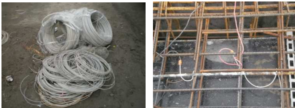
Rys. 2. Z lewej: grzałki stosowane do elektrooporowego grzania betonu; z prawej: połączenie grzałki przewodem zasilającym i powrotnym z transformatorem za pomocą plastikowych złączek (fot. K. Owczarska)
