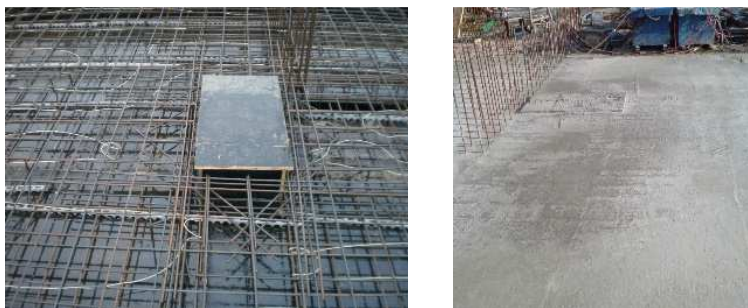
Rys. 10. Z lewej – rozmieszczenie grzałek w okolicy otworów stropowych. Widoczny obszar bez elementów grzewczych. Z prawej – zdjęcie powierzchni stropu po zakończonym procesie elektronagrzewu (fot. K. Owczarska)
