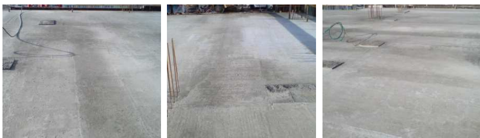
Rys. 6. Widok powierzchni betonu po zakończonym procesie elektronagrzewu. Ciemniejsze pola przedstawiają powierzchnię, gdzie panowała niższa temperatura (fot. K. Owczarska)
