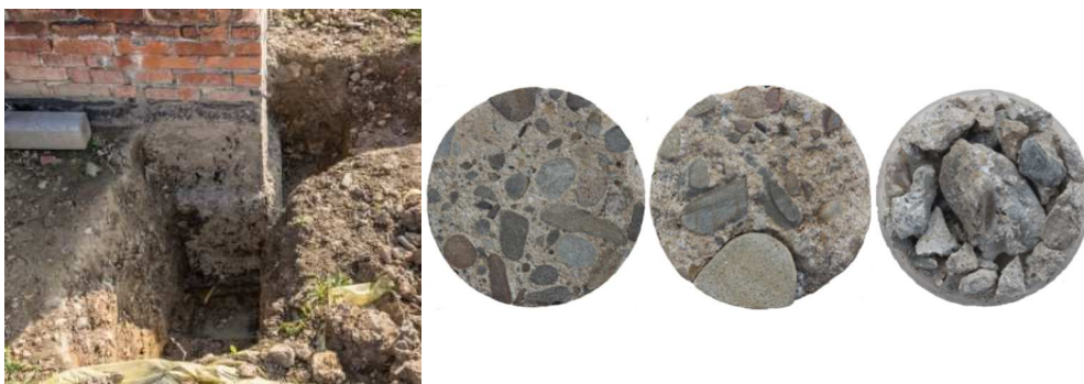
Rys. 6. Odkrywka fundamentu na zewnątrz baraku, obok przykładowe obrazy tekstury betonu pobranego z fundamentów różnych baraków więziarskich
