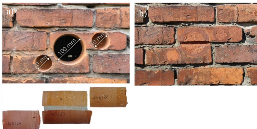
Rys. 8. Układ odwiertów w ścianie murowej baraku więźniarskiego, a) lokalizacja i wymiary odwiertów rdzeniowych, (b) maskowanie otworów powstałych po pobraniu próbek
