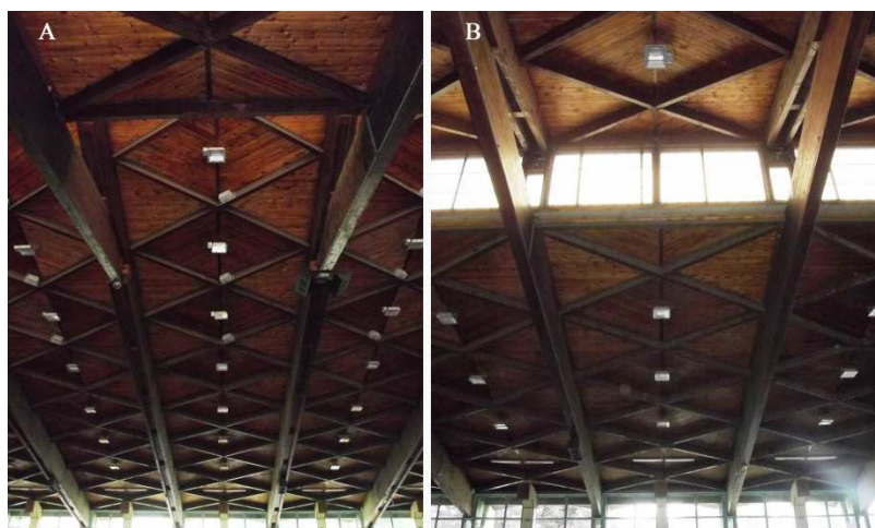
Rys. 5. Połacie dachu od środka (A – połać dłuższa, B – połać krótsza i świetlik)
