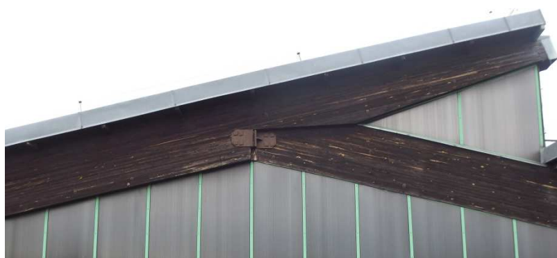
Rys. 4. Połączenie dźwigarów (na przykładzie ramy skrajnej)
