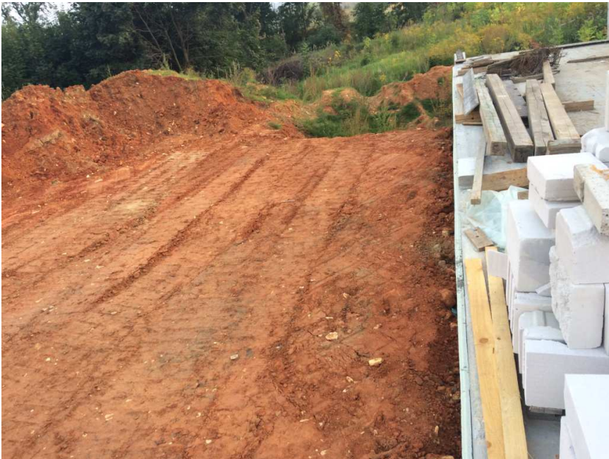
Rys. 5. Ściana oporowa w osi "I"; widoczna wysokość obsypania, grunt zasypowy (głina pylasta) i ślady gąsienic spychacza użytego do zagęszczania gruntu
