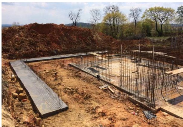
Rys. 7. Dno wykopu na etapie wykonania fundamentów (fot: inwestor); poziom wykopu identyczny jak w listopadzie 2016 roku, na etapie wznoszenia ścian piętra
