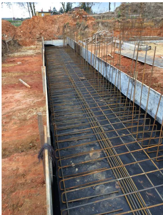
Rys. 6. Ściana oporowa w osi "I" (fot: inwestor); widoczny układ zbrojenia oraz warstwa folii pod podstawą ściany
