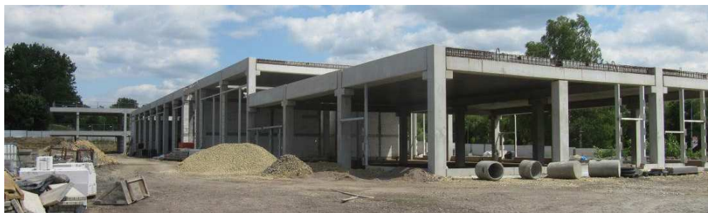
Rys. 2. Widok konstrukcji budynku
