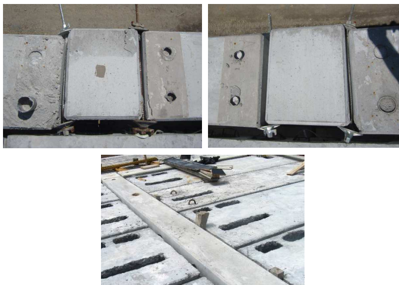
Rys. 5. Próba zabezpieczania przed obrotem belki RL podczas montażu stalowymi ściągami i drewnianymi klinami
