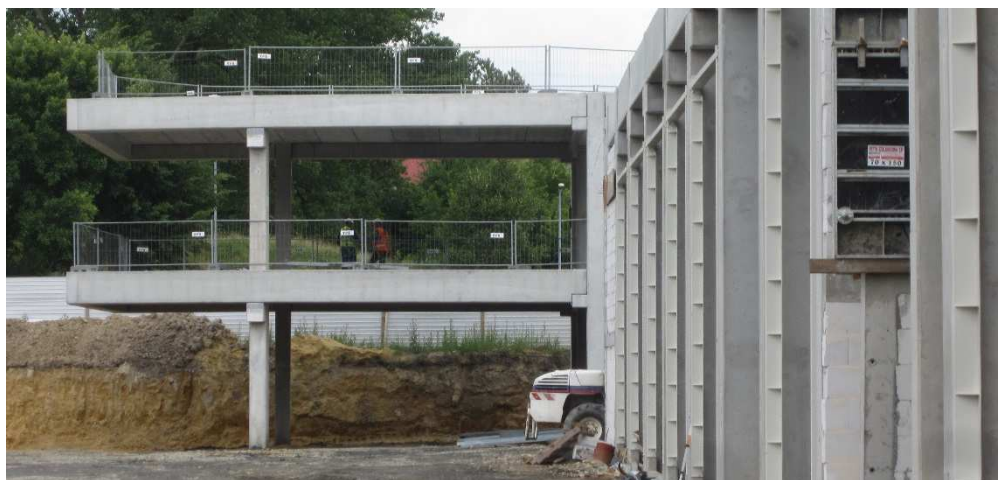
Rys. 12. Belki ze wspornikiem o wysięgu 4,5 m
