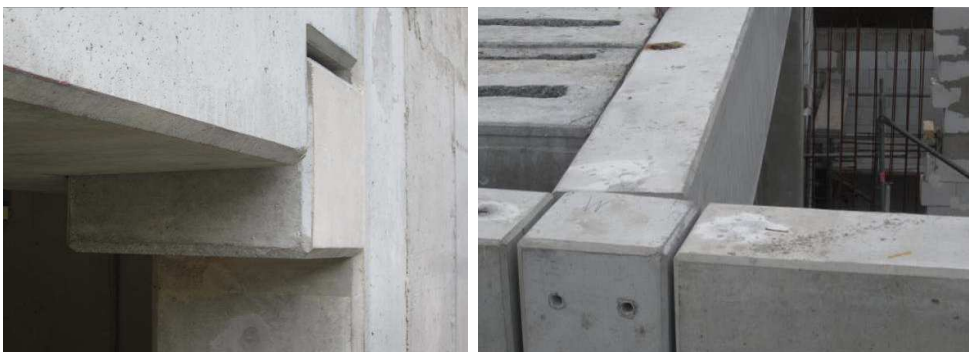
Rys. 4. Przykłady obrotu belek RL na podporze
