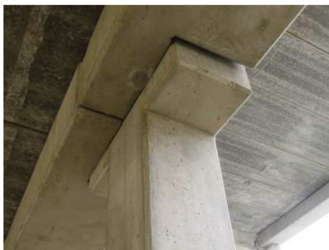
Rys. 10. Oparcie belek RL o słup, po obrocie
