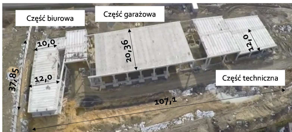
Rys. 1. Widok konstrukcji budynku – fotografia z drona
