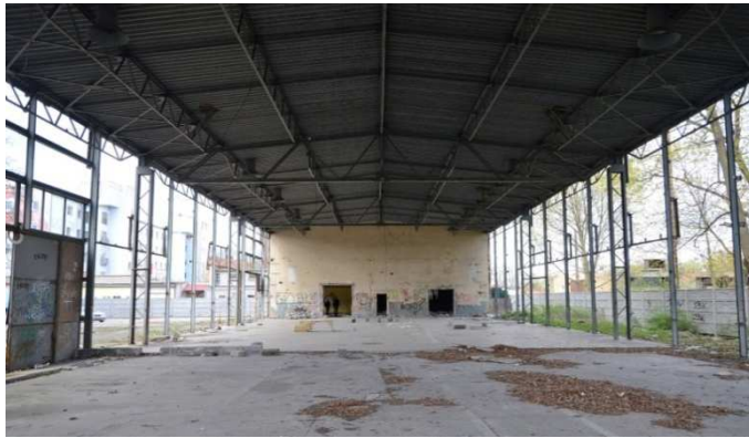
Rys. 7. Widok elementów konstrukcyjnych obiektu handlowego, którego dźwigary wykorzystano do budowy hali na maszyny rolnicze
