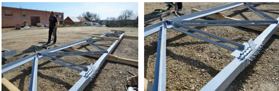
Rys. 9. Widok istniejącego dźwigara wykorzystanego do budowy hali
