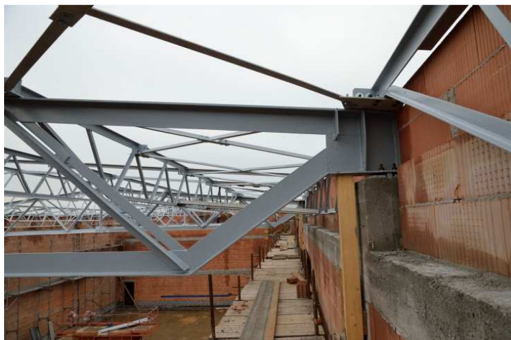
Rys. 12. Osadzenie marek wraz z dźwigarem kratowym na tymczasowym drewnianym elemencie podpierającym
