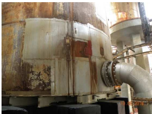
Rys. 4. Naprawy płaszcza wieży
