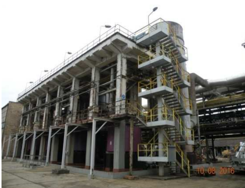
Rys. 2. Żelbetowe pomosty robocze i wanna ochronna
