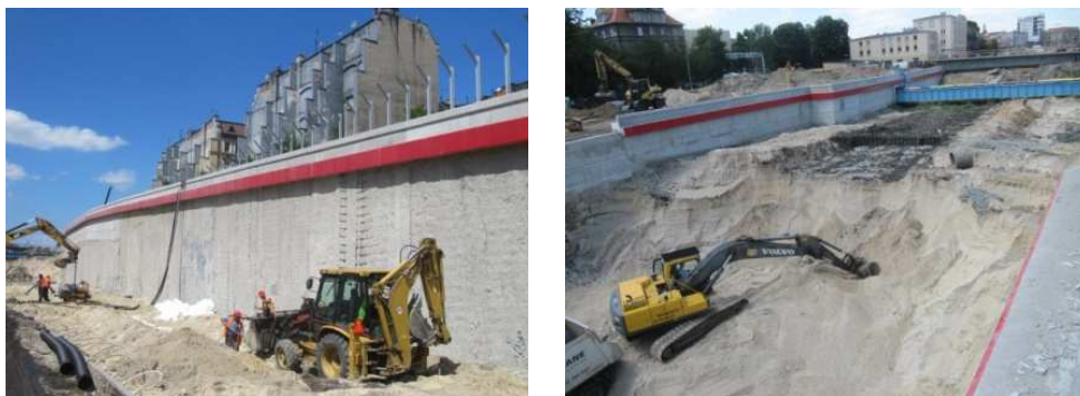
Rys. 5. Wykop za ścianą szczelinową S12
