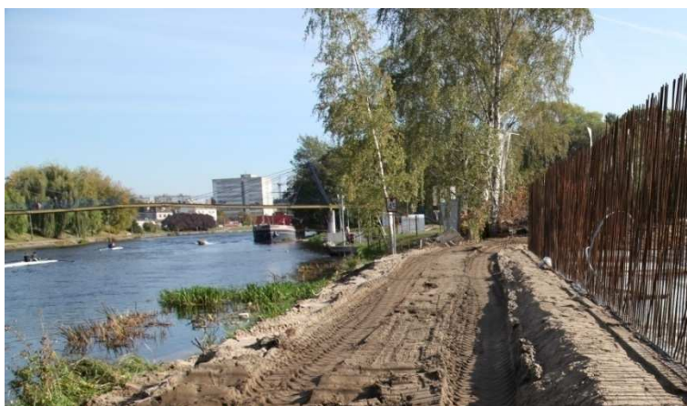
Rys. 2. Widok na niski taras w granicy zabudowy obiektu
