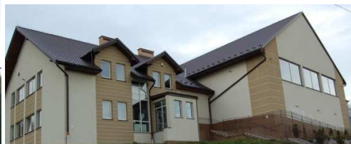
Rys. 5. Widok elewacji południowej, od lewej widoczne: segment socjalny i sala gimnastyczna
