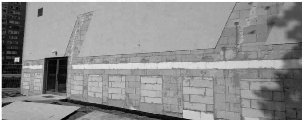
Fot. 4. Widok ogólny ściany po naprawie rys w technologii kłamrowania, zamurowaniu nisz pod mikropale i uzupełnieniu ocieplenia oczezu żelbetowego
