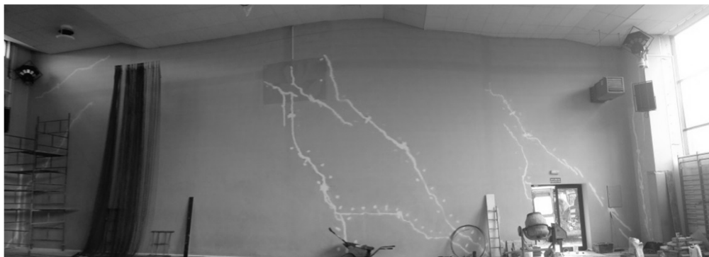
Fot. 3. Widok naprawianej ściany szczytowej sali od strony elewacji wewnętrznej z widocznymi rysami w trakcie prac naprawczych
