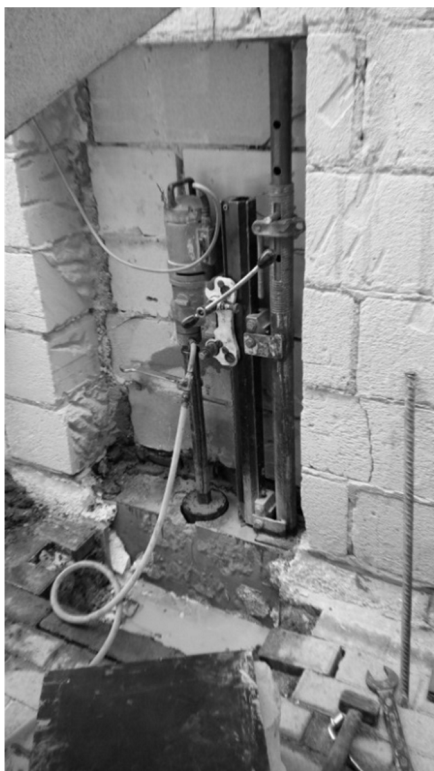
Fot. 2. Widoki z kolejnych etapów realizacji wzmocnienia: (z lewej) przewiert przez łąwę fundamentową w przygotowanej niszy, obok (z prawej) widoczny zestaw do wciskania mikropali
