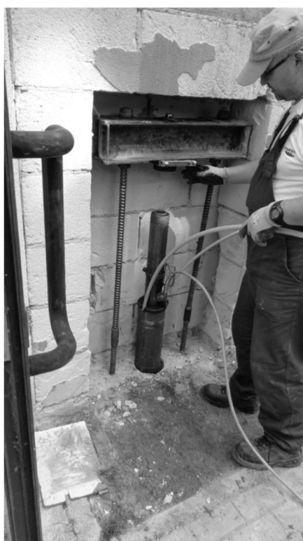
Fot. 2. Widoki z kolejnych etapów realizacji wzmocnienia: (z lewej) przewiert przez łąwę fundamentową w przygotowanej niszy, obok (z prawej) widoczny zestaw do wciskania mikropali
