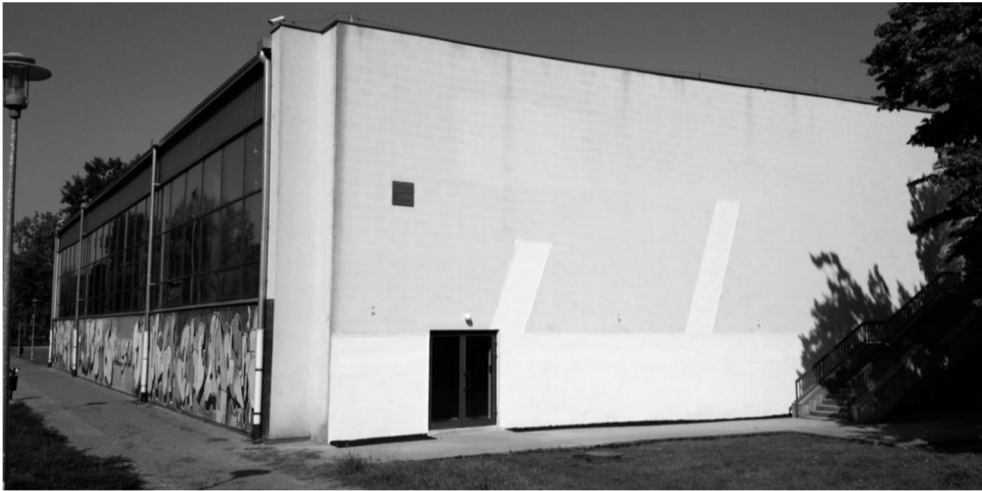
Fot. 1. Widok ogólny analizowanego obiektu – ściana południowa sali gimnastycznej (po naprawie)
