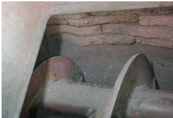
Rys. 1. Widok na wyrobiony kanał ślimaka wygarniający żużel z kotła
