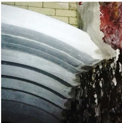
Rys. 2. Sklepienie paleniska w trakcie montażu
