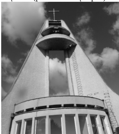
Rys. 2. Widok wieży z poziomu stropodachu dolnego
