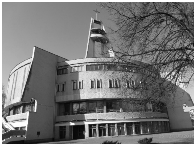
Rys. 1. Elewacja tylna kościoła z widocznymi ścianami wieży
