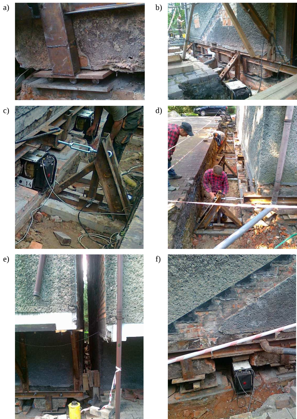
Rys. 10. Prace w budynku: a) podpora przesuwna, b) element prowadzący, c), d) elementy ciągnące, e) dylatacja po przemieszczeniu segmentu w kierunku poziomym, f) siłownik hydrauliczny w czasie nierównomiernego podnoszenia
