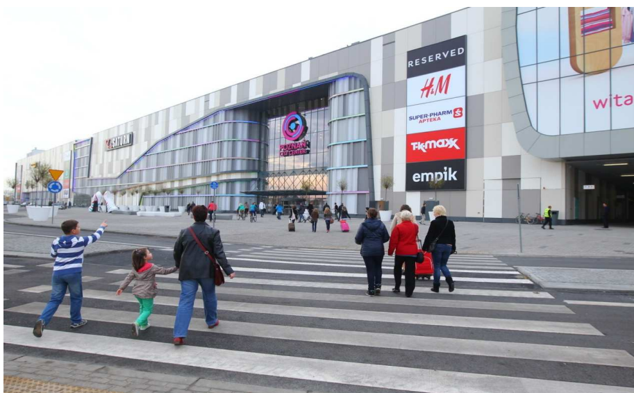
Fot. 1. Widok ogólny budynku PCC
