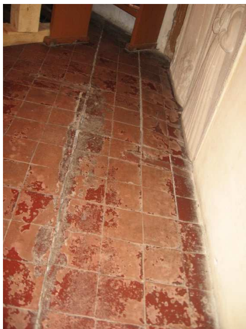
Rys. 5. Posadzka w nawie głównej przy ścianie północno-wschodniej. Nierówności poziomu 10 cm, szczelina szerokości 2 cm
