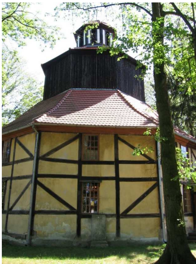
Rys. 1. Elewacja zachodnia kościoła w Sękowicach
