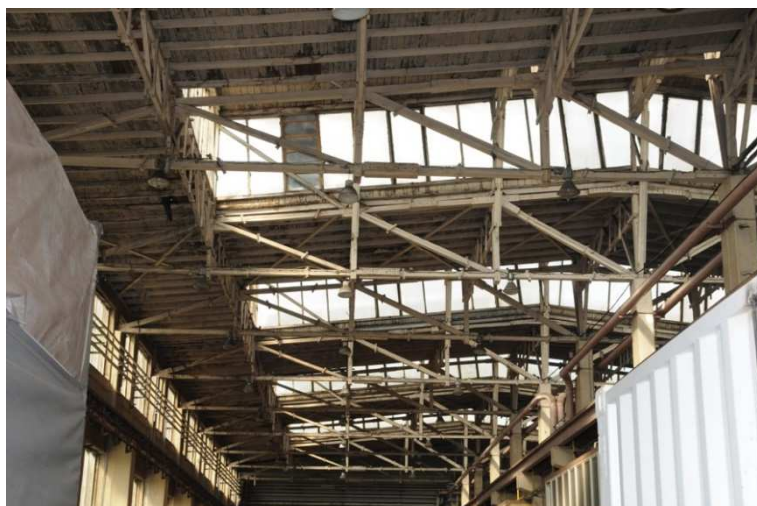
Rys. 2. Widok dźwigarów dachowych w nawie zachodniej
