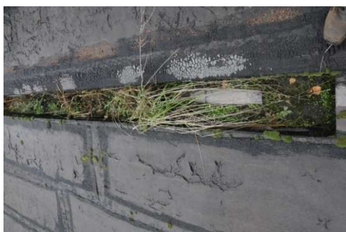
Rys. 17. Zanieczyszczone i niedrożne koryto spustowe
