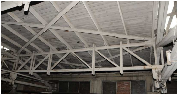
Rys. 4. Widok stężeń połaciowych i płatwi kratowej
