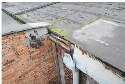
Rys. 16. Brak rynien i rur spustowych
