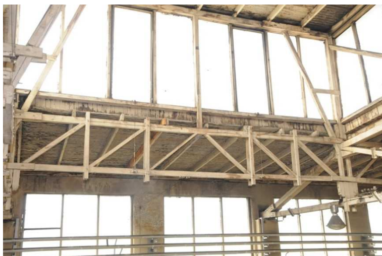
Rys. 3. Widok płatwi kratowej w obrębie naświetla
