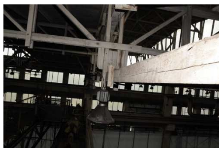
Rys. 6. Widok ugiętego węzła
