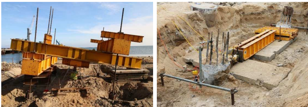
Rys. 8. Konstrukcja stanowiska do próbnego obciążenia pali CFA na obciążenia osiowe (po lewej) i na obciążenia poziome (po prawej)
