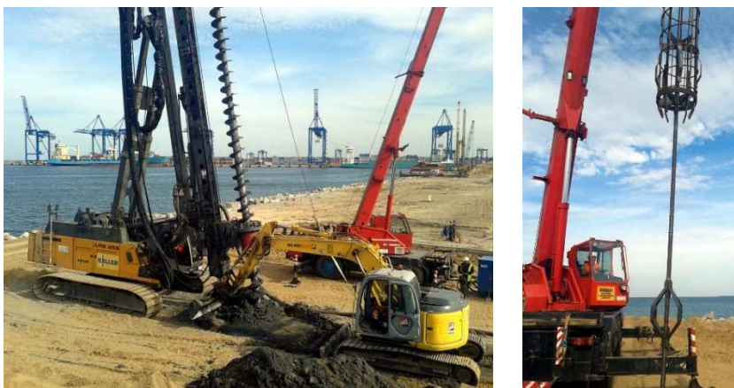
Rys. 9. Wykonanie testowych pali CFA
