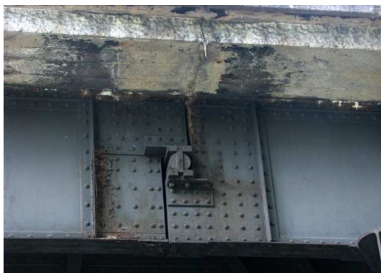
Rys. 5. Konstrukcja dźwigara i przegubu
