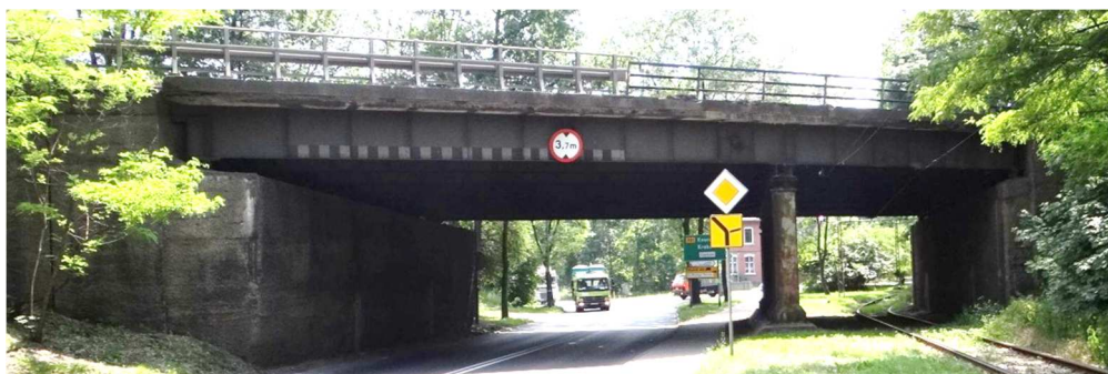
Rys. 1. Widok wiaduktu od strony ul. Tarnopolskiej
