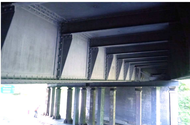
Rys. 6. Konstrukcja przęsła i podpora pośrednia (filar)
