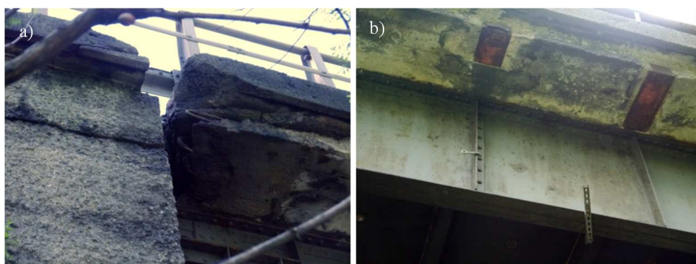
Rys. 9. Uszkodzenia wspornika
