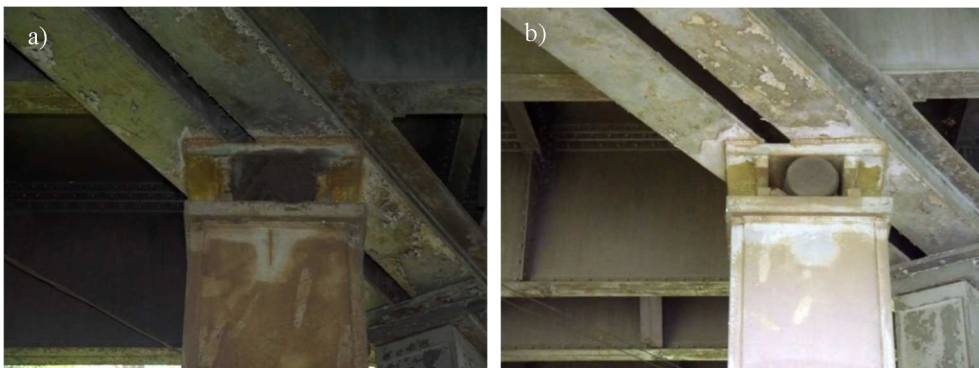
Rys. 13. Skrajne wychylenie łożysk na filarze pod belką: a) drugą i b) szóstą
