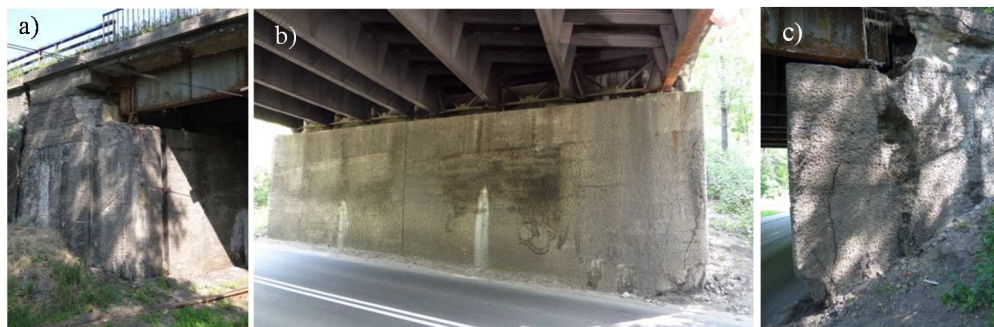
Rys. 10. Uszkodzenia przyczółków
