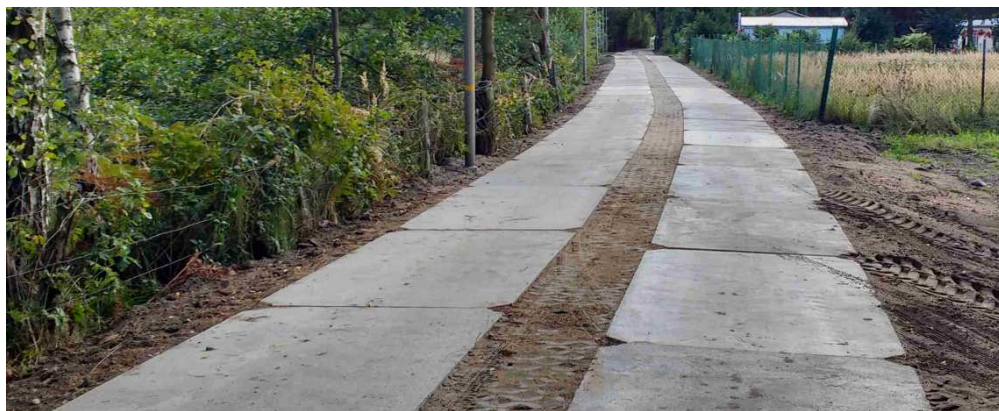
Rys. 2. Widok wykonanej nawierzchni
