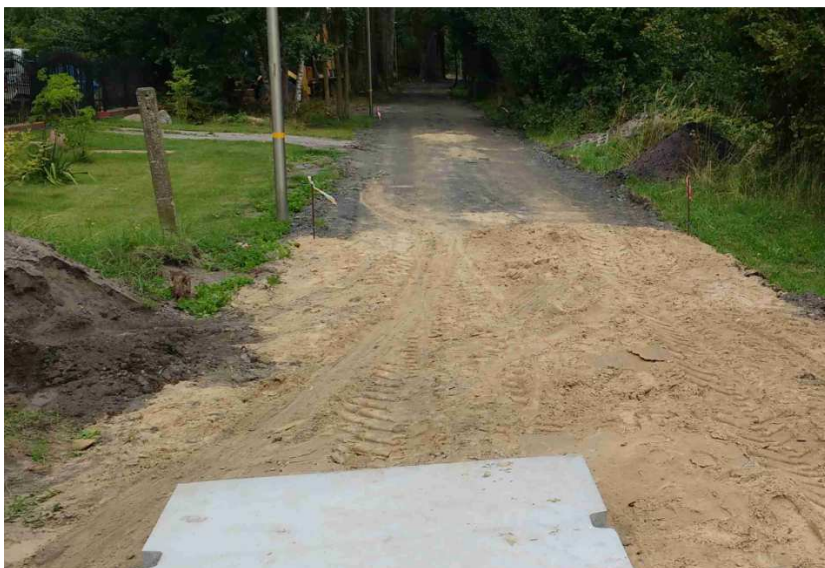
Rys. 5 Droga przygotowana do ułożenia płyt. Z przodu podsypka piaskowa, dalej podbudowa
