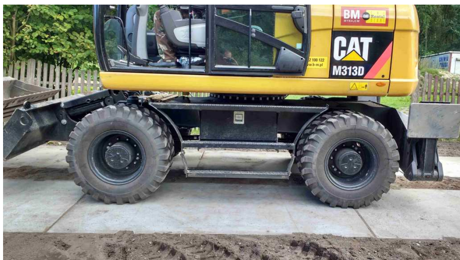
Rys. 6. Koparka kołowa CAT M313D podczas jazdy na nawierzchni
