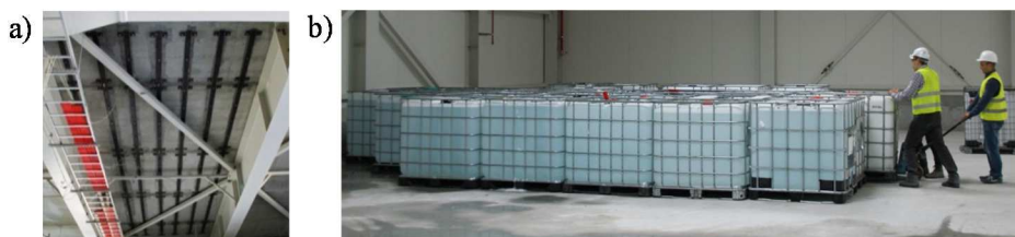
Rys. 7. Próbné wzmocnienie fragmentu stropu i próbné obciążenie: a) widok wzmocnienia za pomocą płaskowników, b) ustawianie balastu na stropie
