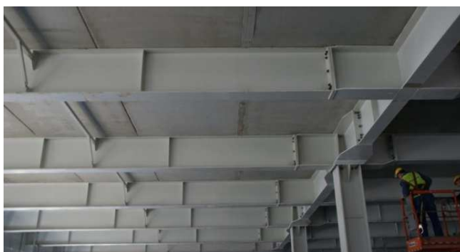
Rys. 1. Widok fragmentu konstrukcji stalowej pod stropem parteru
