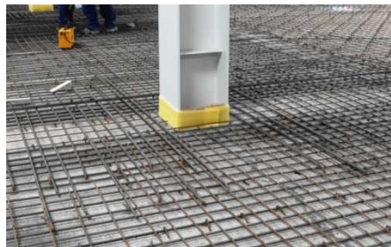
Rys. 11. Dodatkowe zbrojenie górne płyty w sąsiedztwie słupa
