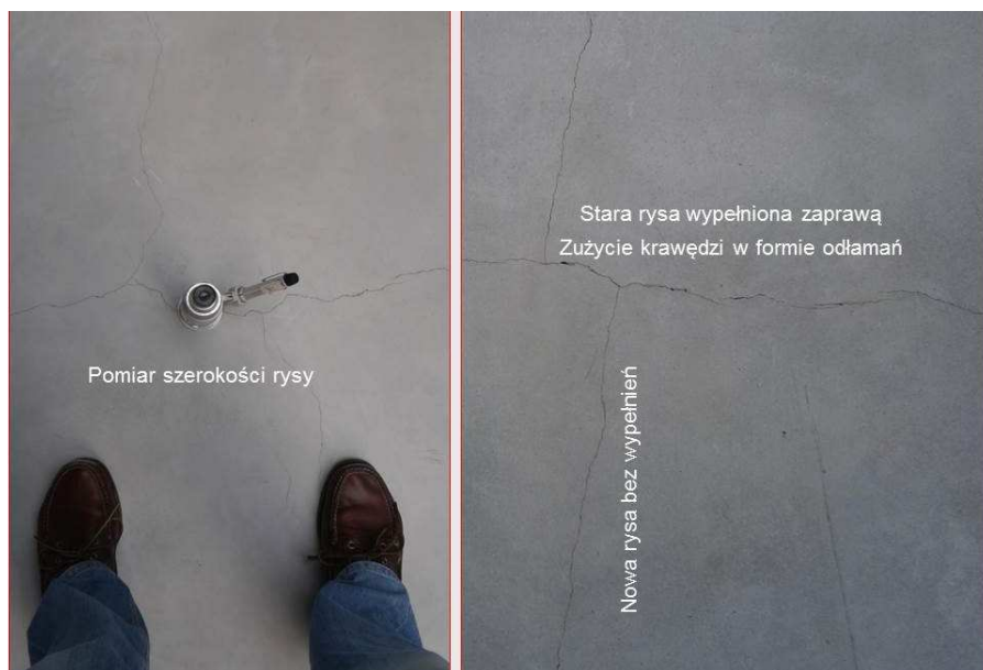
Rys. 6. Wygląd rys
