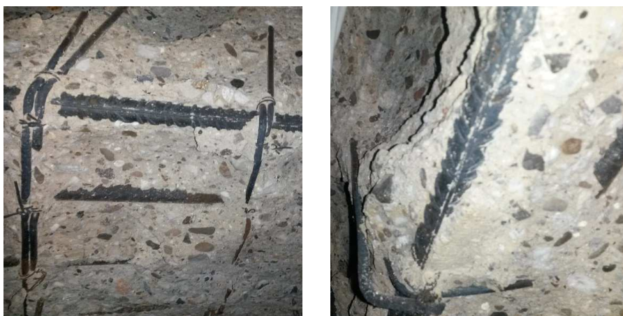
Rys. 9 Połączenie strzemion w belkach głównych
