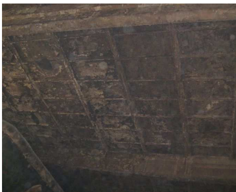
Rys. 6–7. Konstrukcja stropodachu – widoczny brązowo-czarny nalot i ślady korozji
