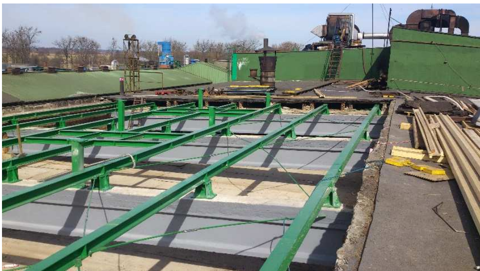
Rys. 13. Naprawiona konstrukcja dachu – montaż płatwi stalowych
