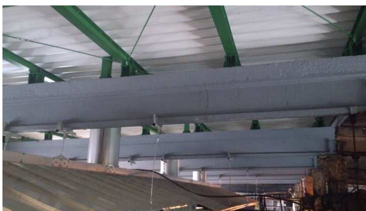
Rys. 16. Naprawiona konstrukcja dachu – widok od dołu
