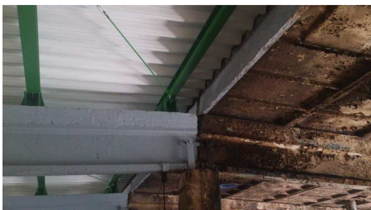
Rys. 15. Miejsce styku nowej (naprawionej) konstrukcji dachu z częścią istniejącą
