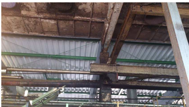
Rys. 14. Widok z dołu na styk naprawionej i istniejącej konstrukcji dachu
