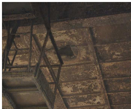
Rys. 6–7. Konstrukcja stropodachu – widoczny brązowo-czarny nalot i ślady korozji
