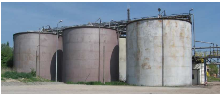
Rys. 1. Widok ogólny zespołu 5 zbiorników
