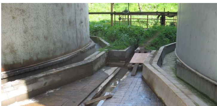
Rys. 2. Posadowienie zbiorników na tacach antykorozyjnych
