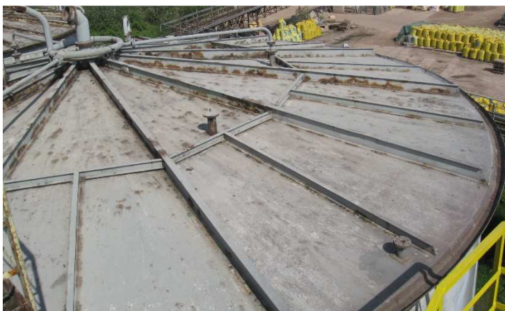
Rys. 3. Konstrukcja dachu zbiornika
