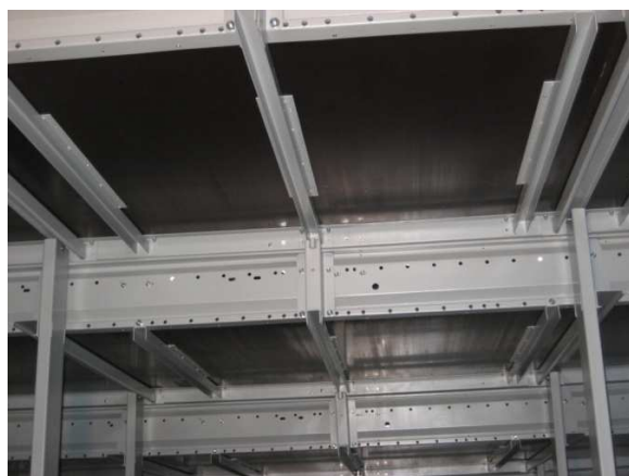
Rys. 11. Konstrukcyjne zabezpieczenie rygli podestowych
