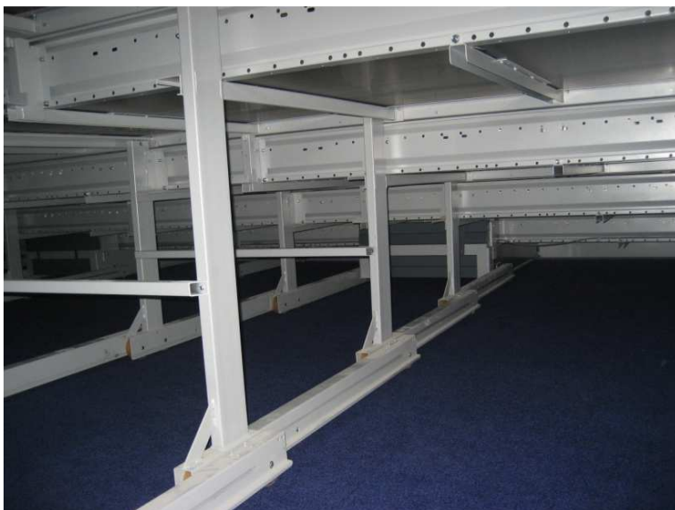
Rys. 6. Widok konstrukcji dolnych rzędów jednego z segmentów trybuny
