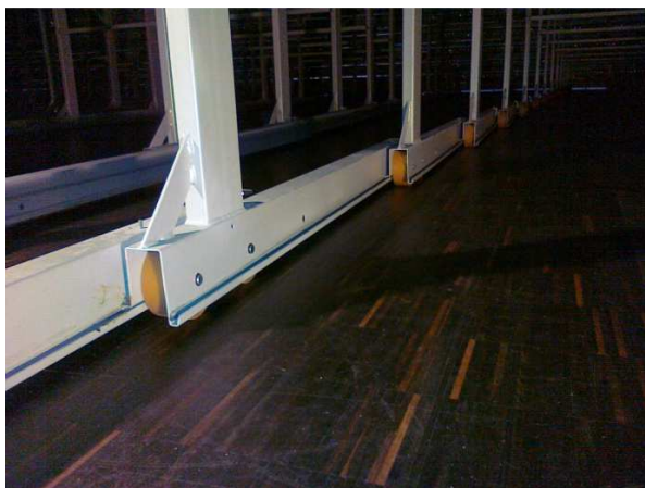
Rys. 8. Podporowe elementy jezdne umożliwiające rozkładanie i składanie trybuny
