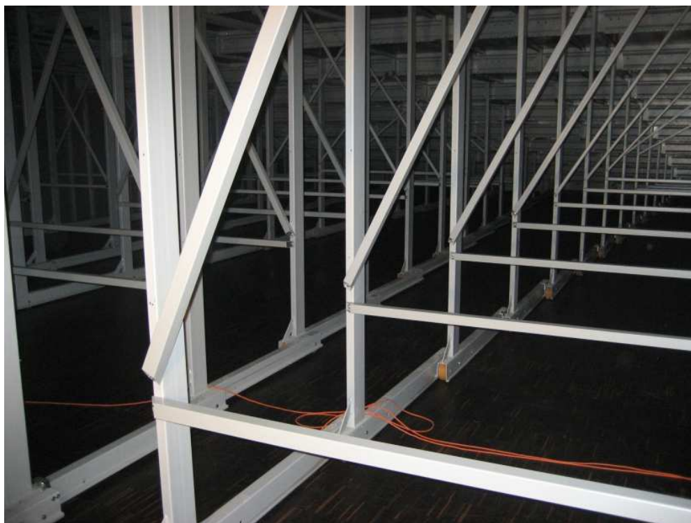
Rys. 15. Widok konstrukcji wsporczej trybuny po jej przekonstruowaniu
