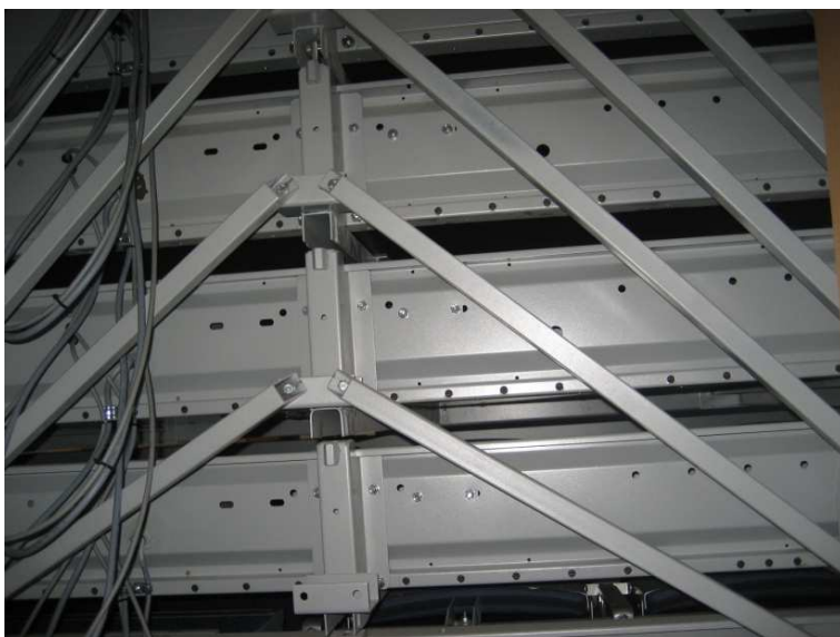
Rys. 7. Belki podestowe oraz stężenia typu V w złożonej konstrukcji trybuny
