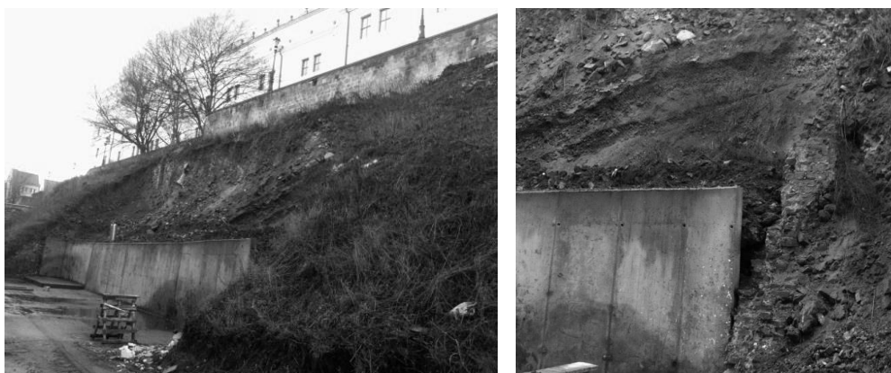
Rys. 2. Fragment budowy wzmocnienia skarpy południowo-wschodniej Zamku
