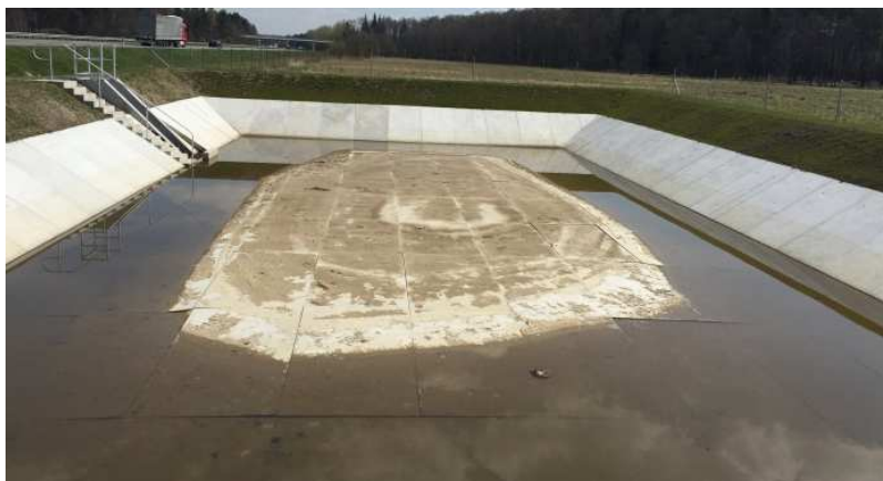
Rys. 6. Widok podniesionego dna zbiornika
