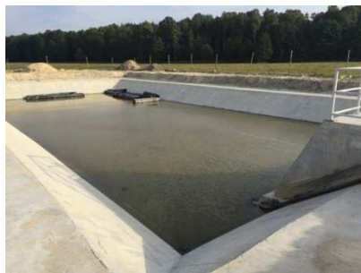
Rys. 9. Odbudowa zbiornika – usunięcie warstw piasku i geomembrany
