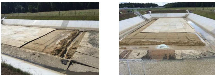
Rys. 8. Odbudowa zbiornika – rozbiórka płyt drogowych
