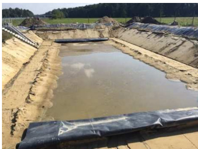
Rys. 9. Odbudowa zbiornika – usunięcie warstw piasku i geomembrany
