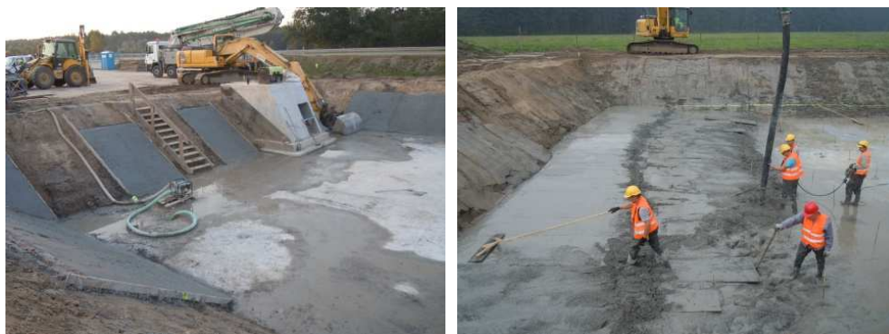
Rys. 4. Układanie „chudego” betonu i betonowanie dna
