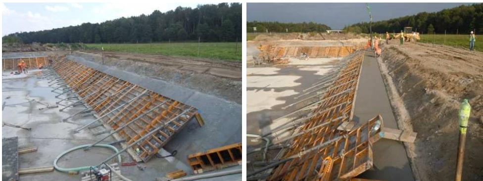
Rys. 5. Szalunki na skarpach i betonowanie skarp
