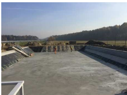
Rys. 10. Odbudowa zbiornika – nowa izolacja, betonowanie dna i skarp
