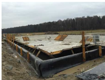
Rys. 10. Odbudowa zbiornika – nowa izolacja, betonowanie dna i skarp
