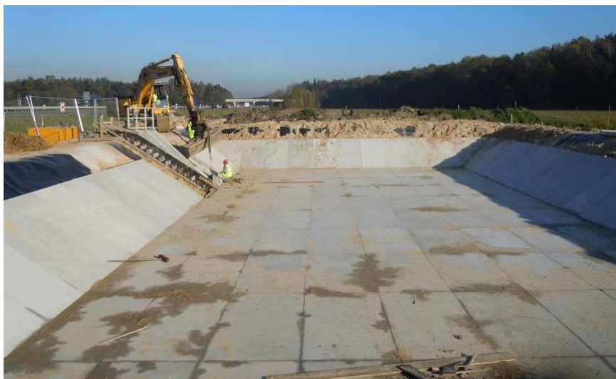
Rys. 1. Widok zbiornika w końcowej fazie budowy
