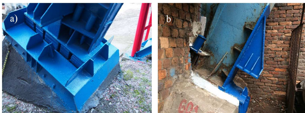
Rys. 8. Widok konstrukcji pomocniczych do prowadzenia rektyfikacji wież szybowych: a) wieża szybowa nr 1, b) wieża szybowa nr 2
