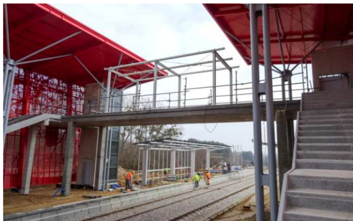
Rys. 3. Widok konstrukcji przystanku PKM „Kiełpinek” w Gdańsku
