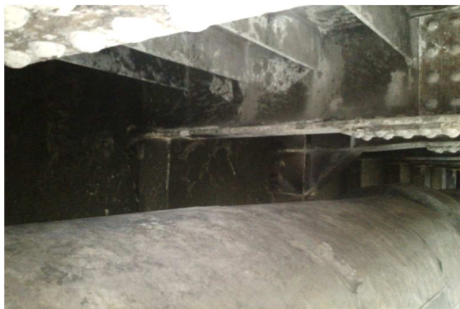
Rys. 5. Widok okopconej stalowej konstrukcji mostu nad magistralą wodociągową
