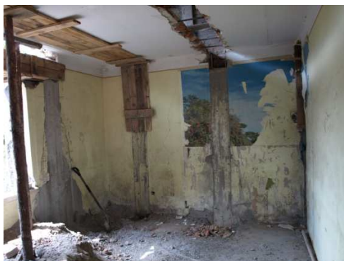
Rys. 4. Wzmocnienie ceramicznej płyty Kleina
