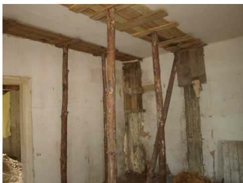
Rys. 4. Wzmocnienie ceramicznej płyty Kleina
