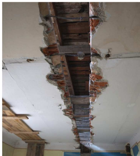
Rys. 5. Bruzdy wykonane w płycie ceramicznej. Brak stemplowania płyty stropowej. Wycięta bednarka zbrojąca płytę
