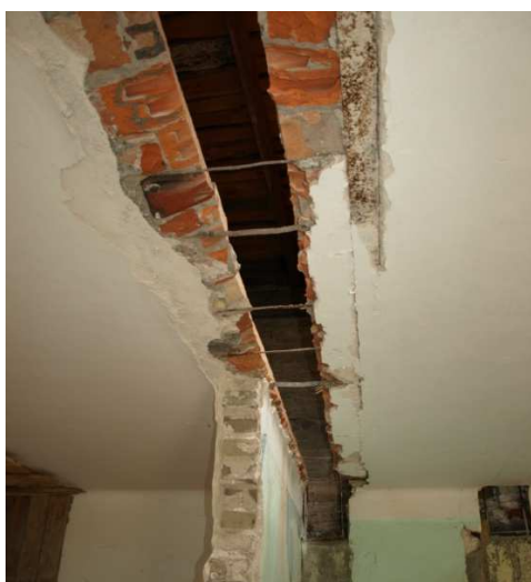
Rys. 5. Bruzdy wykonane w płycie ceramicznej. Brak stemplowania płyty stropowej. Wycięta bednarka zbrojąca płytę
