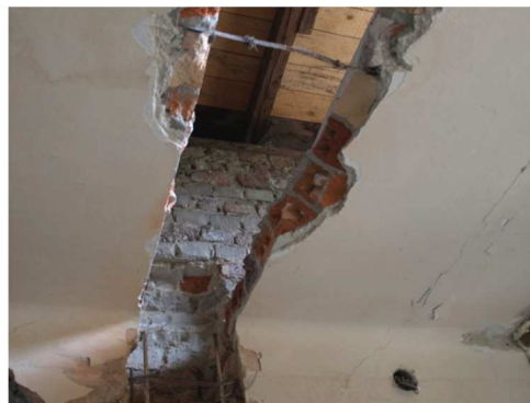
Rys. 6. Szczegóły wykonanych bruzd w płycie ceramicznej. Brak stemplowania płyty stropowej. Powycinana bednarka
