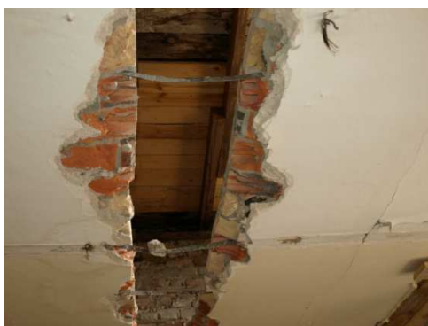
Rys. 6. Szczegóły wykonanych bruzd w płycie ceramicznej. Brak stemplowania płyty stropowej. Powycinana bednarka
