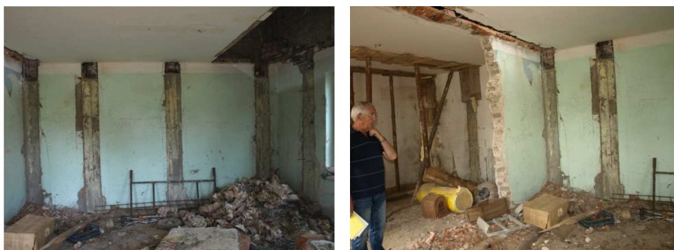
Rys. 3. Żelbetowe słupy usztywniające konstrukcję budynku
