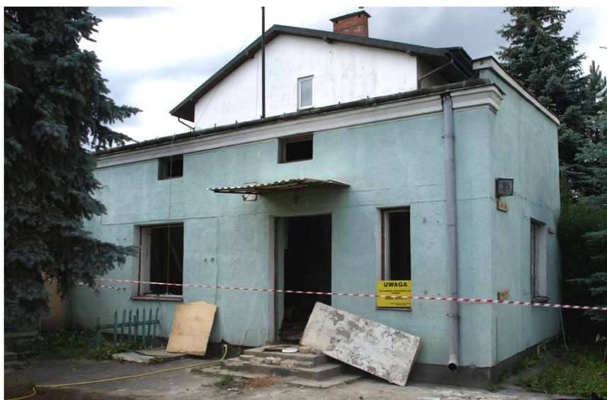
Rys. 2. Elewacja frontowa, południowo wschodnia, budynku w trakcie jego rozbudowy
