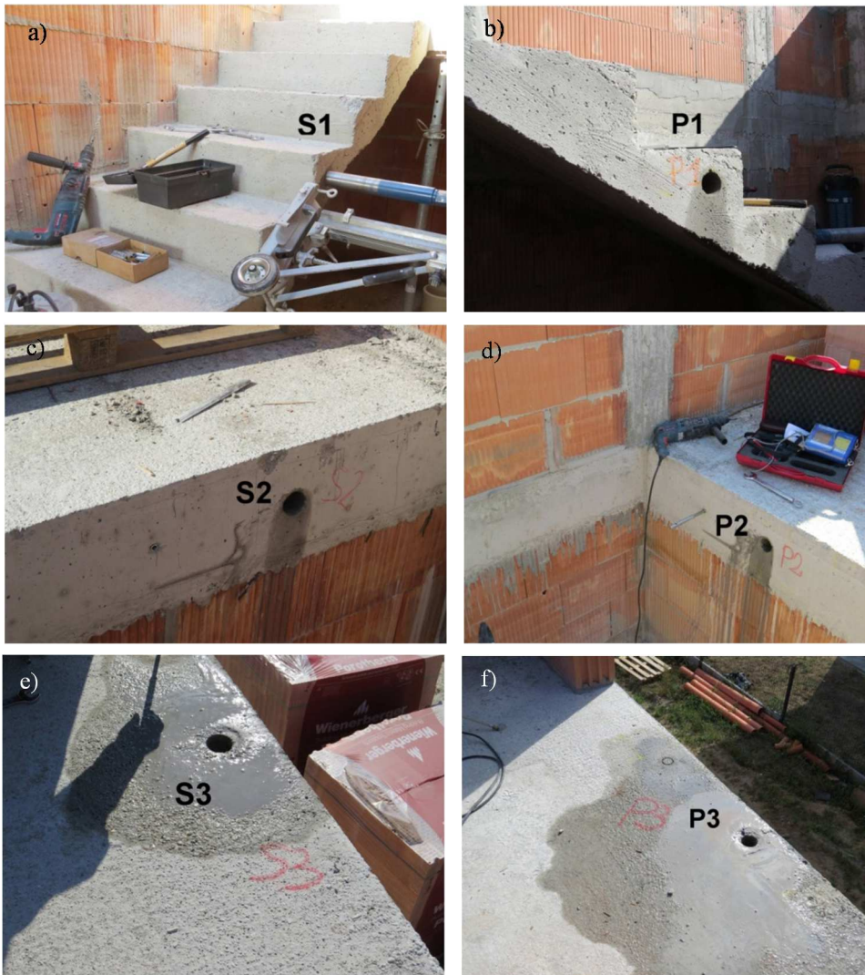
Rys. 7a, b, c, d, e, f. Widoki miejsc pobrania odwiertów rdzeniowych: S1, S2, S3, P1, P2, P3
